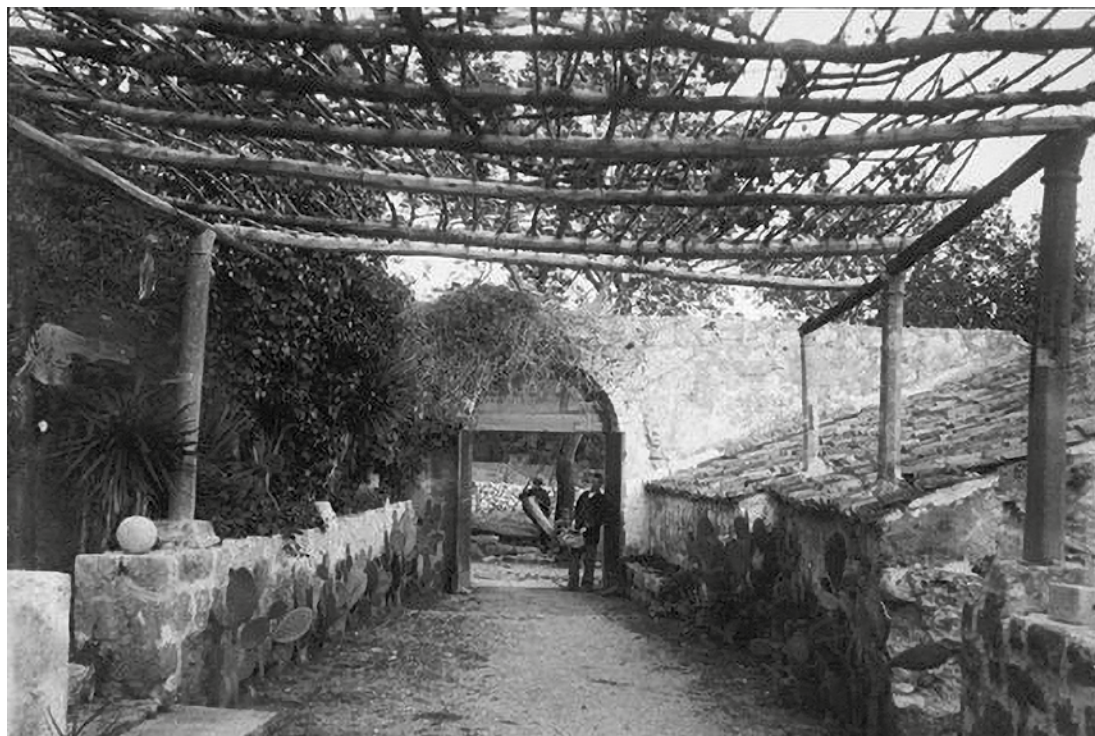
Pogled na mlinicu, ogradni zid i ulaz u posjed sa strane potoka, oko 1905. godine
