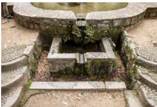
Detalj ispred bazena fontane, rješenje odvodnje i bočne stube formirane od dijelova renesansnih klesanih kamenih okvira prozora prvog kata ladanjske kuće
