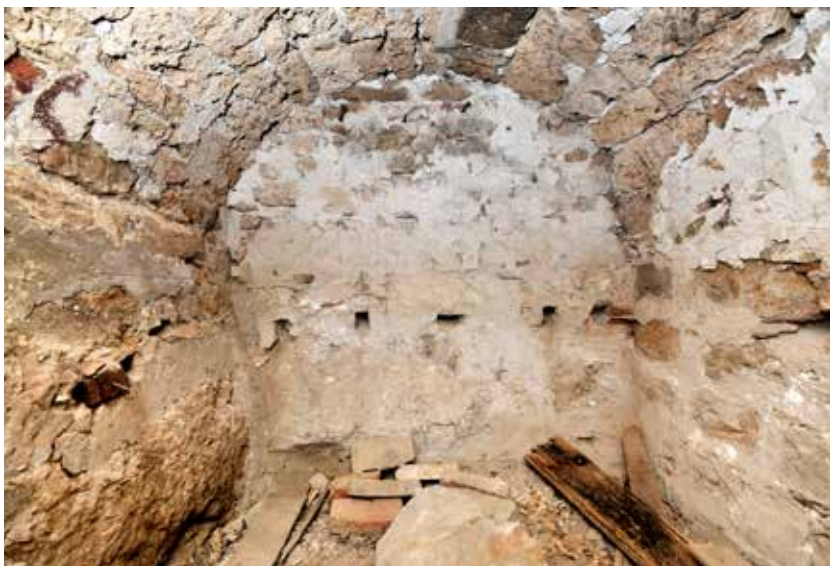
Podrum ladanjske kuće, prostor ispod stubišta
