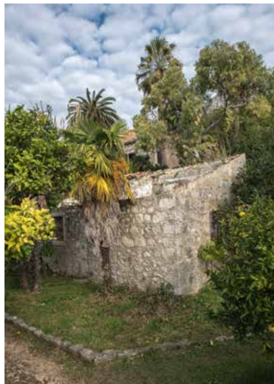
Zgrada s krušnom peći
