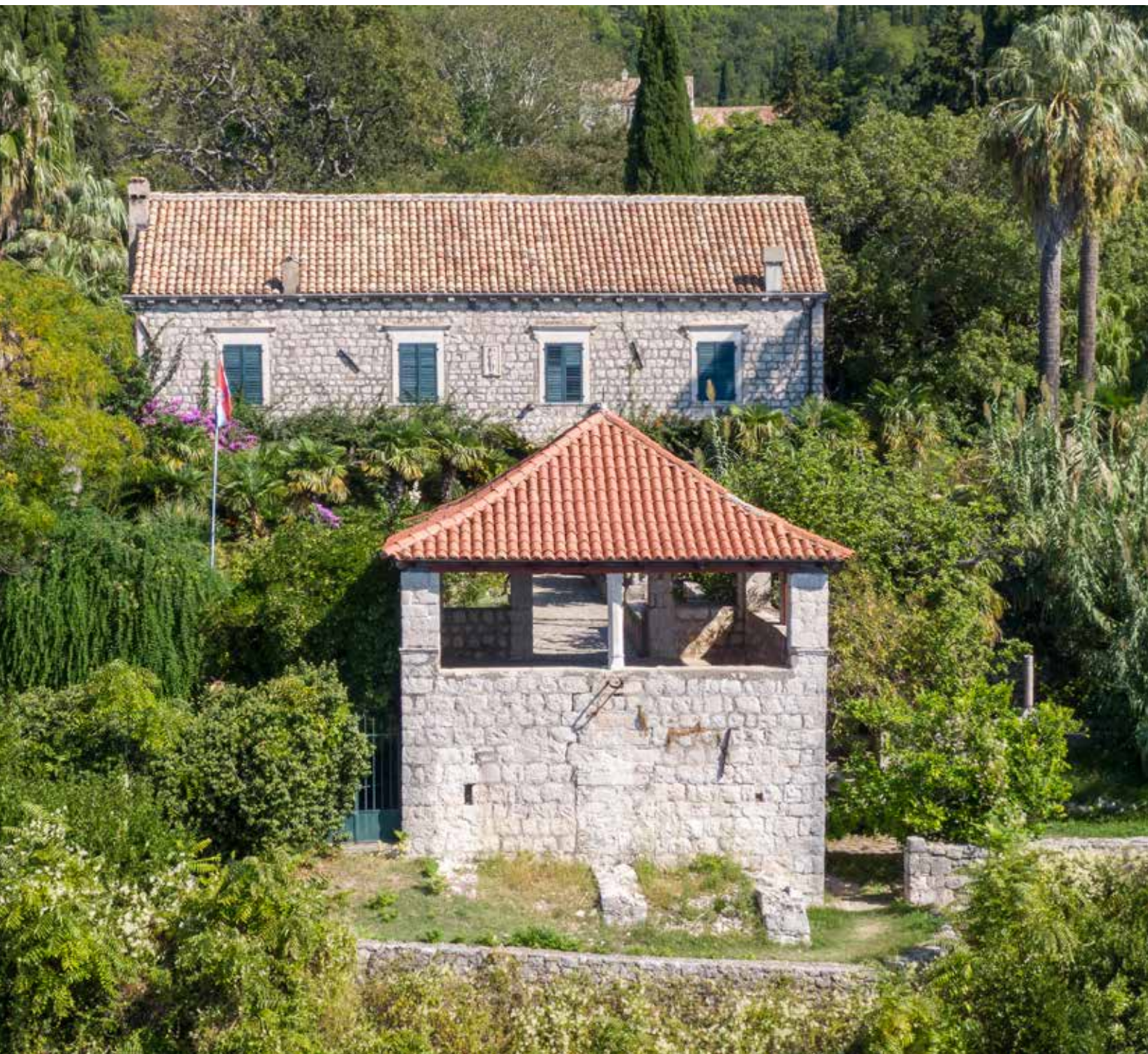
Paviljon ispred ladanjske kuće nakon uklanjanja kontrafora, pogled s juga
