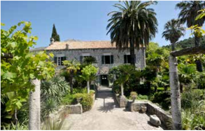
Ladanjska kuća obitelji Gučetić, glavno pročelje
