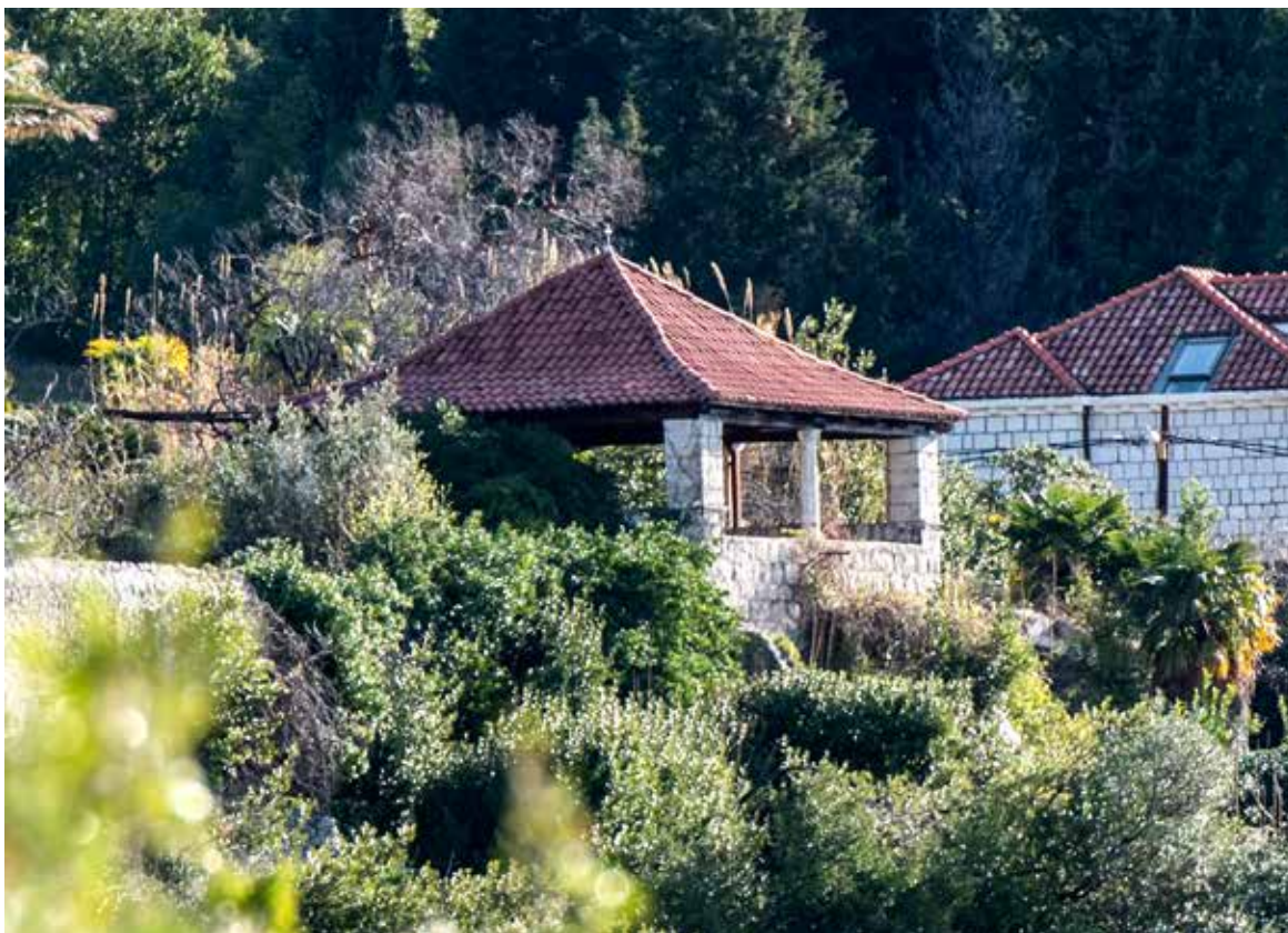
Pogled na paviljon s jugozapada
