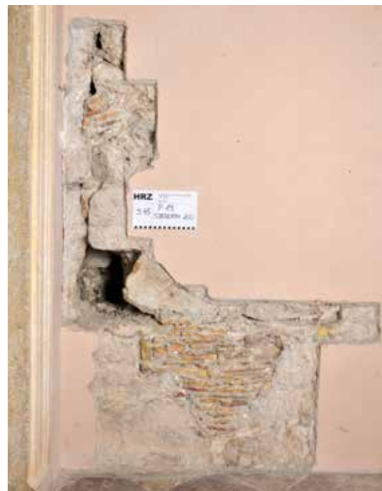
Nalaz zazidanog pila (kamenog umivaonika), sjeverni zid velike sale na prvom katu ladanjske kuće
