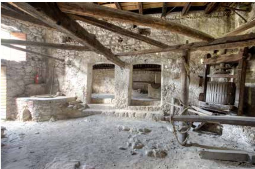
Mlinica, unutrašnjost, središnja prostorija, pogled na sjever
