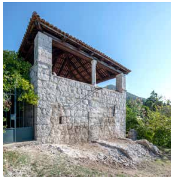
Paviljon, pročelje prema moru nakon uklanjanja prizidanih kontrafora
