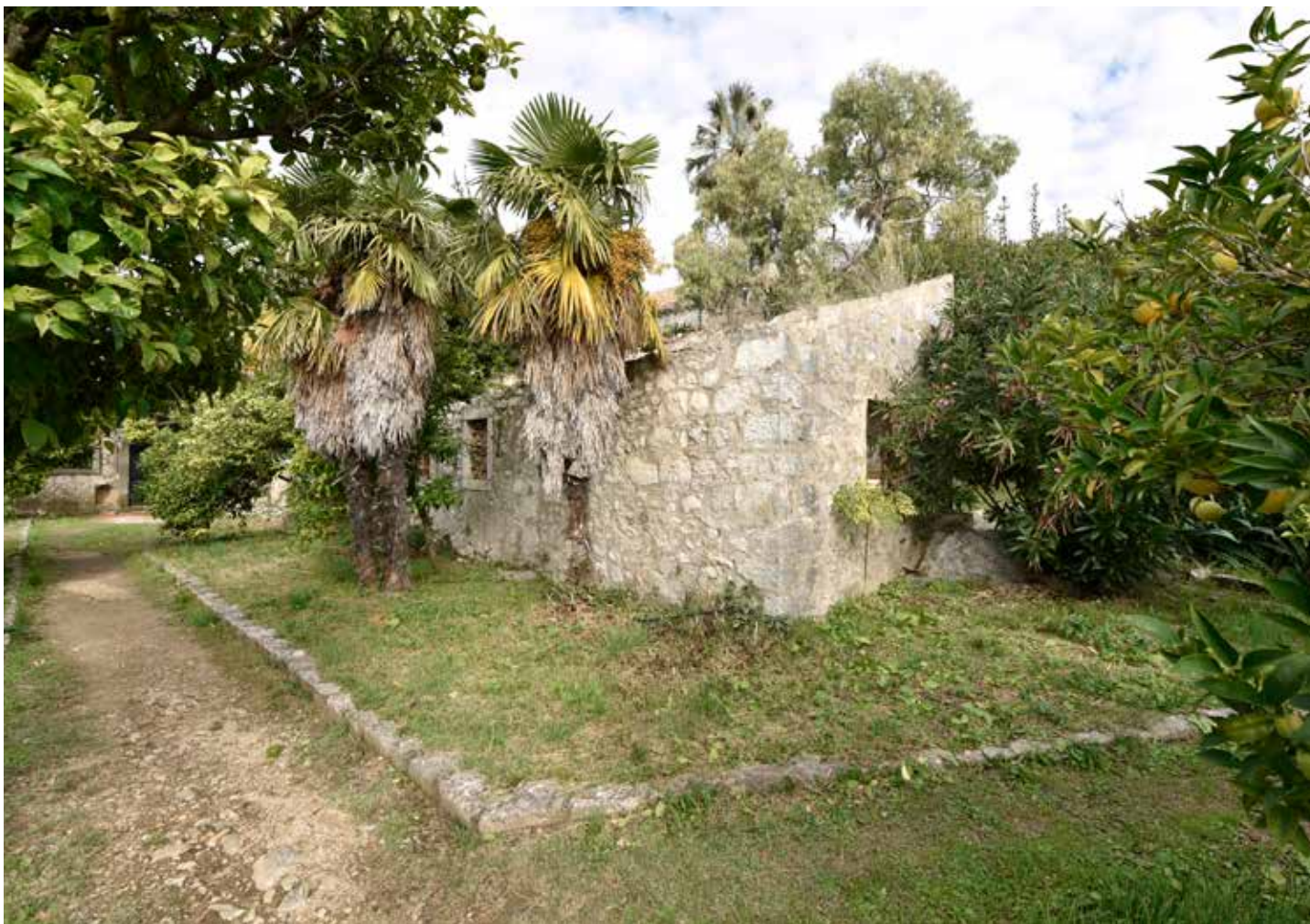
Zgrada s krušnom peći
