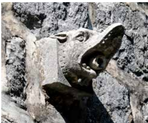
Klesani kameni element (rigol) na sjevernom pročelju
