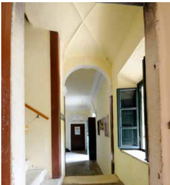
Odmorište između kuhinje i saloče u prizemlju
