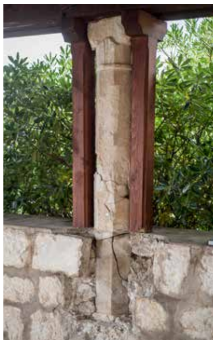
Nalaz zazidanog donjeg dijela stupa, zapadni parapet terase paviljona
