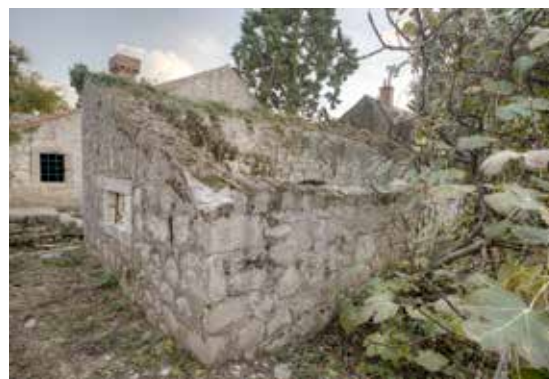
Spremište, pogled sa sjeverozapada
