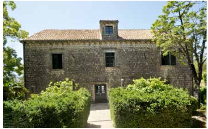
Ladanjska kuća obitelji Gučetić, stražnje pročelje
