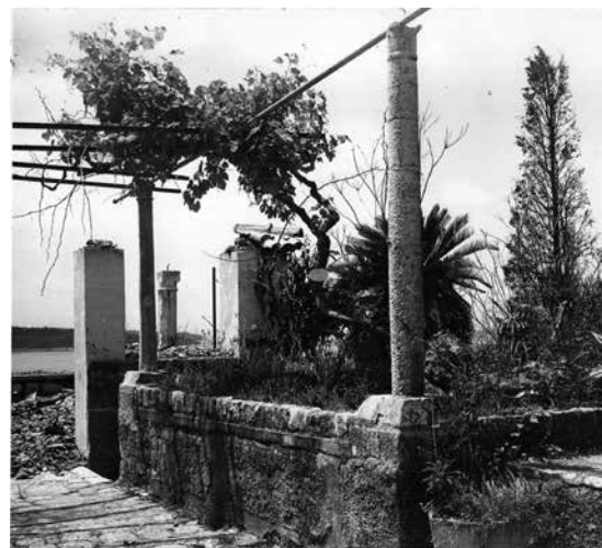
Oštećenja paviljona nakon požara u drugoj polovini 20. stoljeća
