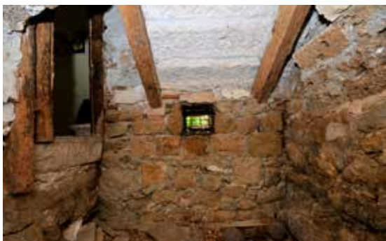
Prostor podruma ispod stubišta
