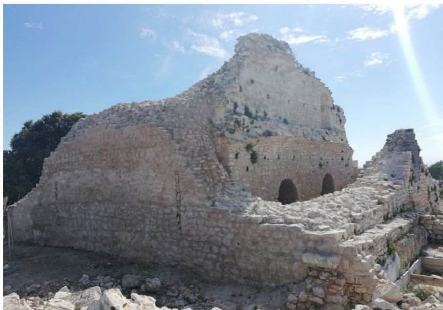
Rovinj (Turnina), srednjovjekovna kula. Istočni zid kule prije i nakon provedenih konzervatorsko-restauratorskih radova. Snimke: J. Višnjčić, 2019. i 2020.
