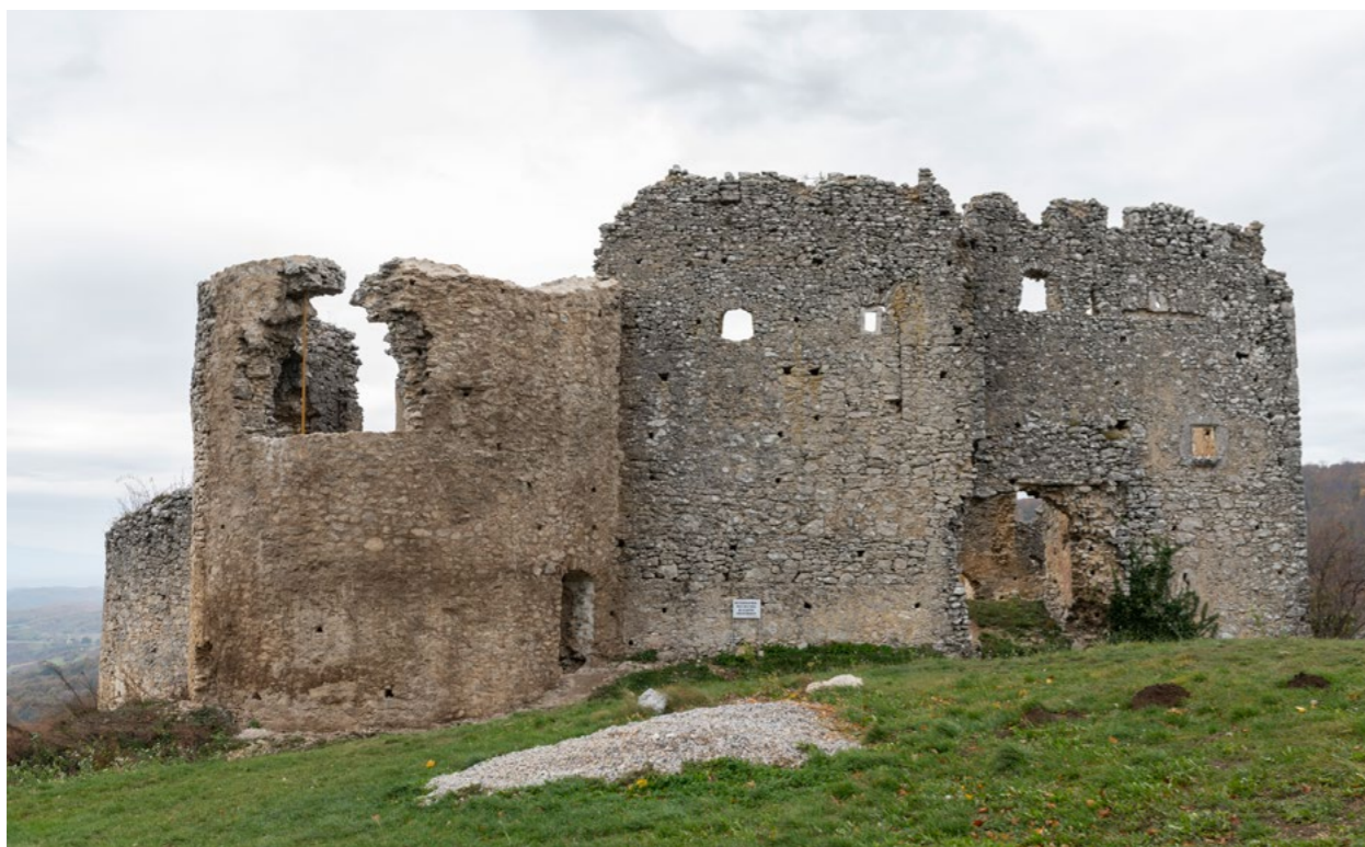
Budinščina, Stari grad Milengrad, sjeveroistočno pročelje. Stanje prije i nakon radova. Snimke: Vektra d.o.o., 2015. i I. Marinković, 2020.
