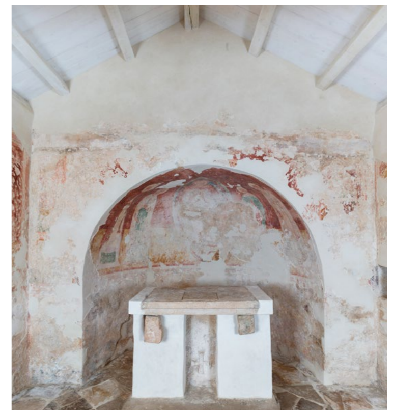
Vodnjan, crkva sv. Katarine, istočni zid i apsida. Stanje prije i nakon radova. Snimke: J. Kliska, 2012. i K. Gavrilica, 2020.
