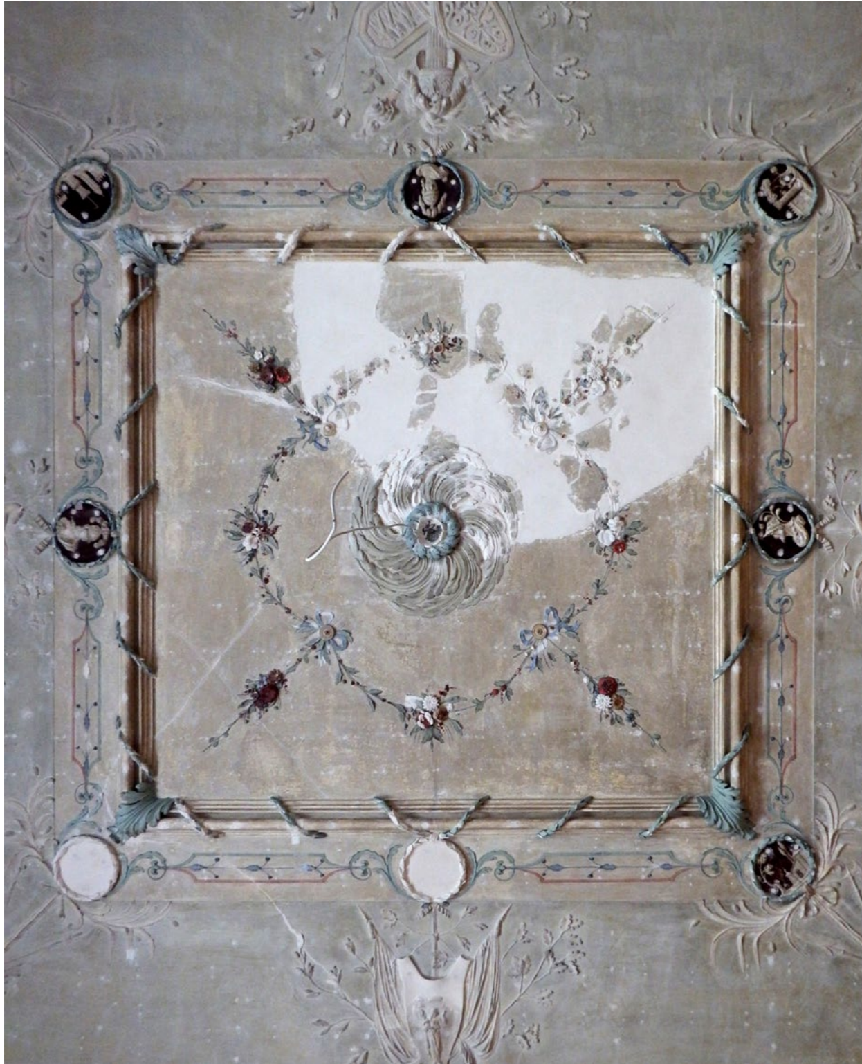
Rijeka, upravna zgrada bivše Tvornice „Rikard Benčić“, Salon s vedutama, strop. Stanje tijekom i nakon radova. Snimke: J. Kliska, 2019. i G. Tomljenović, 2020.
