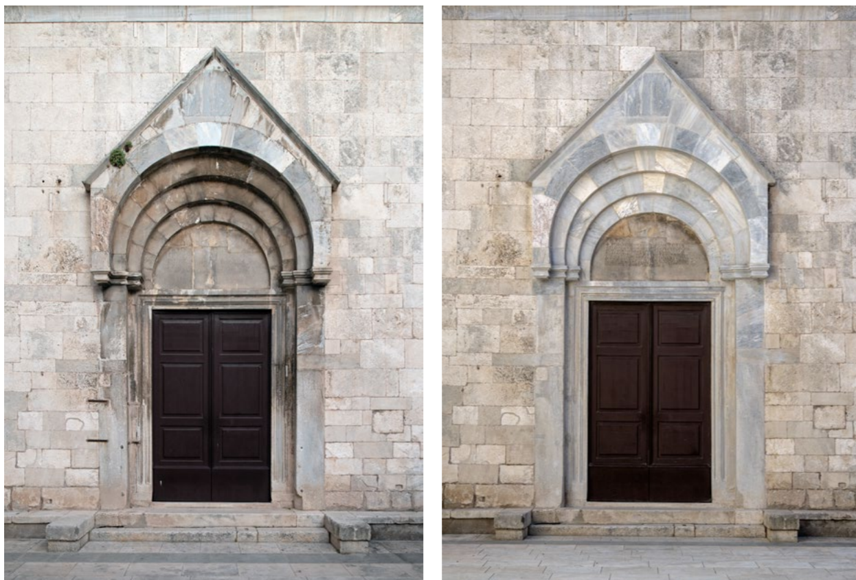
Zadar, crkva sv. Krševana, glavni portal. Stanje prije i nakon radova. Snimke: J. Kliska, 2018. i 2020.
