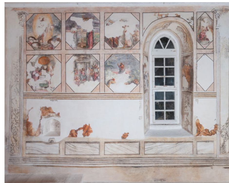
Otok Lopud, Lopud, crkva Gospe od Šunja. Južni zid svetišta tijekom i nakon radova. Snimke: K. Gavrilica, 2008. i 2019.
