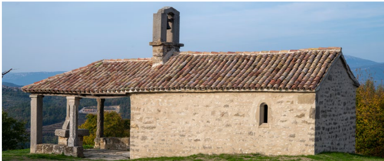
Draguč, crkva sv. Roka. Stanje prije i nakon radova izvedenih u 2019. godini. Snimka: J. Kliska, 2019.
