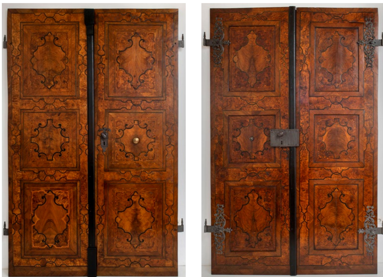
Ilok, franjevački samostan i crkva sv. Ivana Kapistrana. Nepoznati autor, drvene vratnice vrata refektorija, prednja strana (oko 1730.). Stanje nakon stolarske sanacije i nakon radova. Snimke: J. Kliska, 2019.
