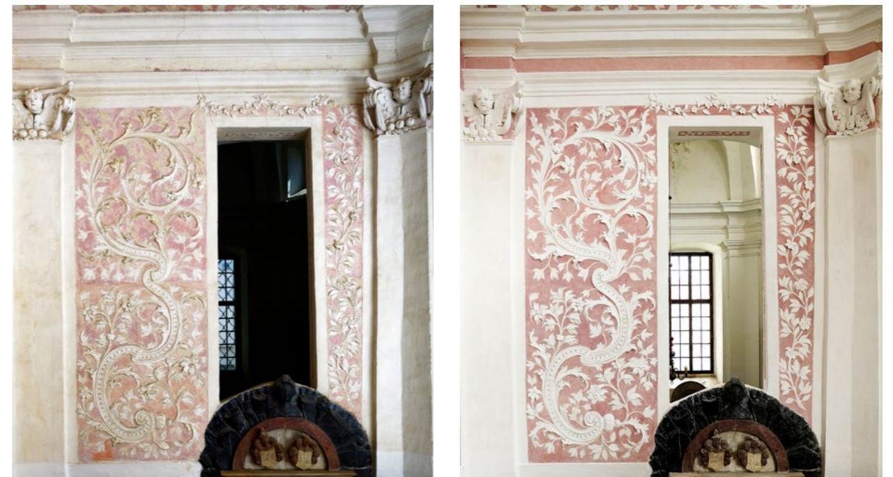
Lepoglava, bivši pavlinski samostan i crkva Bezgrešnog začeća Blažene Djevice Marije, kapela Presvetog Trojstva (Patačić). Istočni zid kapele prije i nakon radova. Snimke: J. Škudar, 2018. i 2019.
