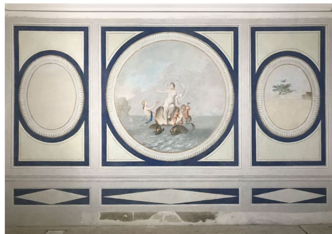
Rijeka, upravna zgrada bivše tvornice „Rikard Benčić“. Sjeverni zid prostorije 222 prije i nakon radova. Snimke: J. Kliska, 2019.
