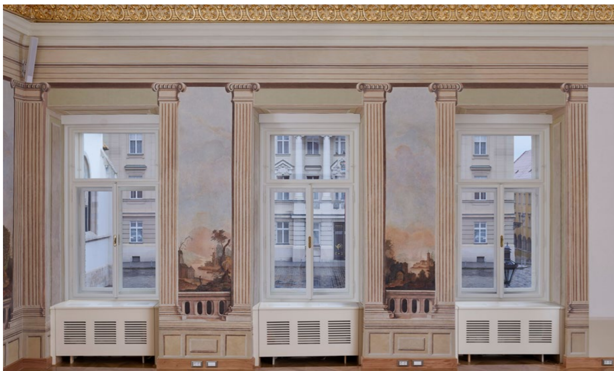
Zagreb, Banski dvori, Dvorana „Ban Jelačić“. Zidni oslik na istočnom zidu prije i nakon radova. Snimke: N. Vasić, 2018. i G. Tomljenović, 2019.
