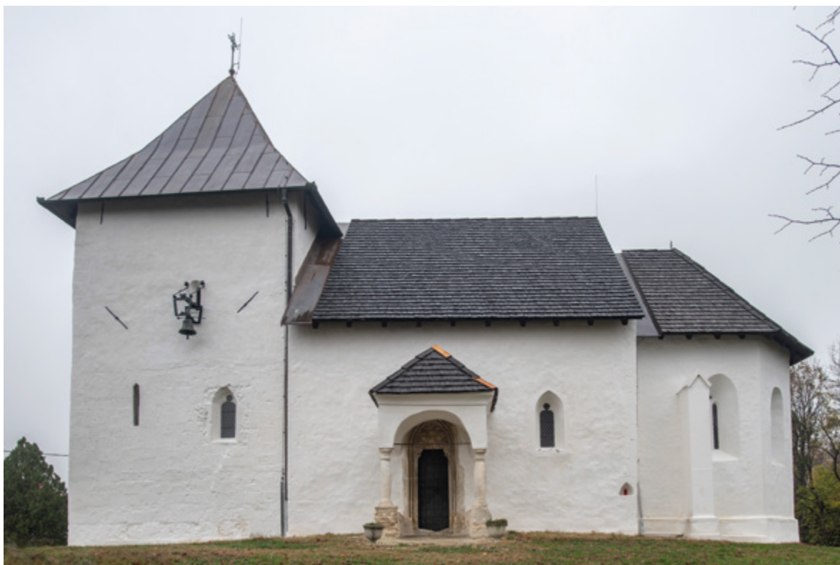
Belec, crkva sv. Jurja. Pogled na južno pročelje prije i nakon završetka radova. Snimke: A. Škevin Mikulandra, 2013. i N. Vasić, 2018.
