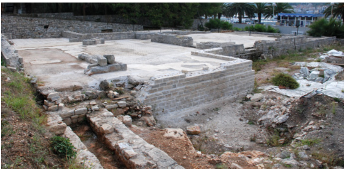
Otok Vis, Vis, antičke terme. Sjeverozapadni dio istočnog krila termi prije i nakon podizanja rekonstruktivnog zida. Snimke: A. Gluhan, 2018.
