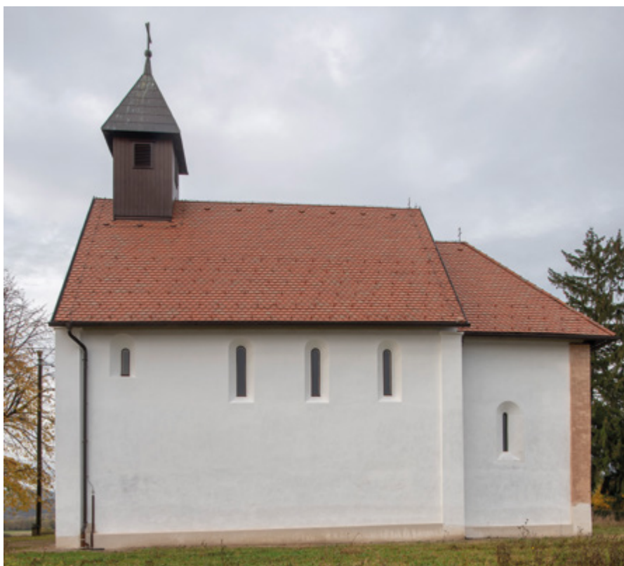
Novo Mjesto, kapela sv. Petra i Pavla. Pogled na južno pročelje prije i nakon izvođenja radova. Snimke: G. Tomljenović, 2017. i J. Kliska, 2018.
