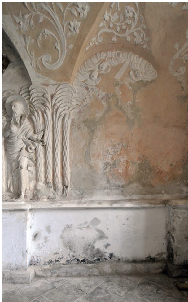
Lepoglava, crkva Bezgrešnog začeća Blažene Djevice Marije, štukatura u predvorju. Detalj istočnog zida prije radova. Fotografija: J. Škudar, 2011.
