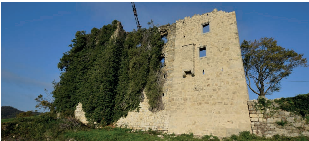
Paz, kaštel Paz. Pogledi na kaštel s južne strane prije i nakon završetka građevinskih radova. Fotografija: J. Višnjčić, 2017.
