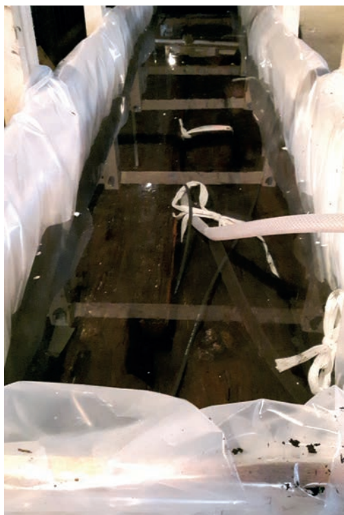
Sisak, Željeznički kolodvor. Proces impregnacije drvene građe. Fotografija: M. Mustaček, 2017.
