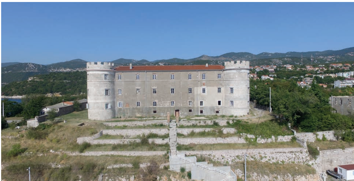
Kraljevica, Novi grad Zrinskih. Pogled na južno pročelje. Fotografija: I. Kraljević, 2017.
