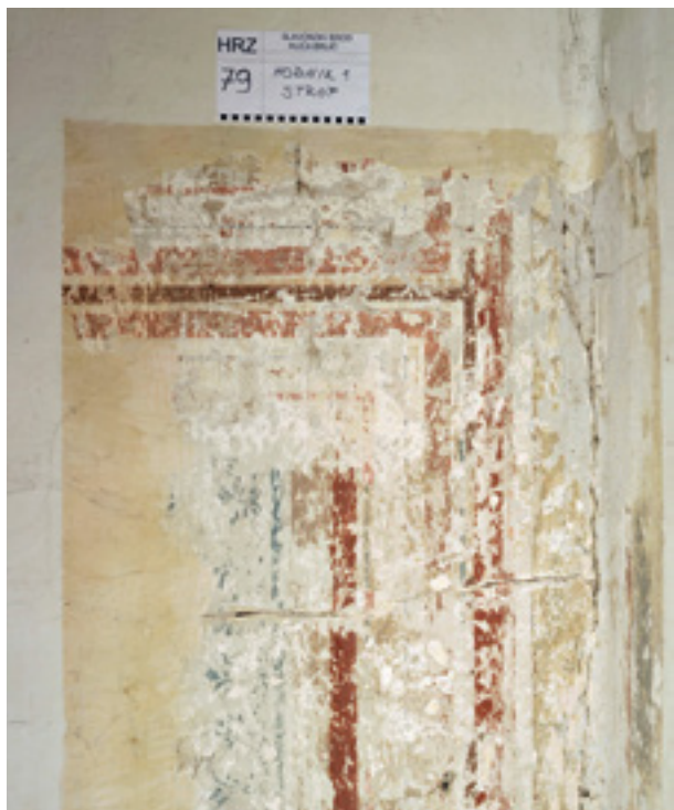
Slavonki Brod, kuća Brlić, sonda otvorena na stropu s utvrđena dva ranija sloja oslika
