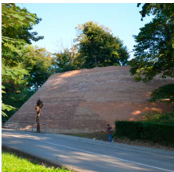
Ilok, rekonstruirani podzid Barbakana, pogled s jugoistoka
