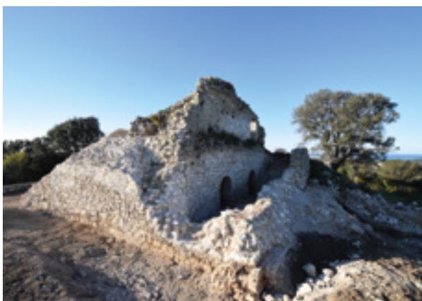
Turnina, pogled na ostatke kule s istočne strane nakon provedenog čišćenja, 2015
