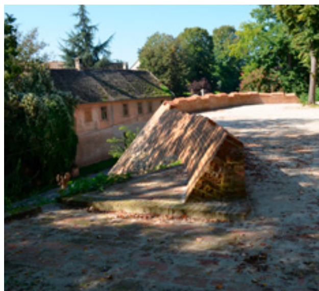
Ilok, pogled s istoka na gornju zonu rekonstruiranog podzida Barbakana
