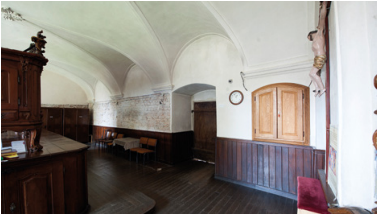
Slavonski Brod, franjevački samostan, sakristija, pogled na zapadni zid prije radova.
