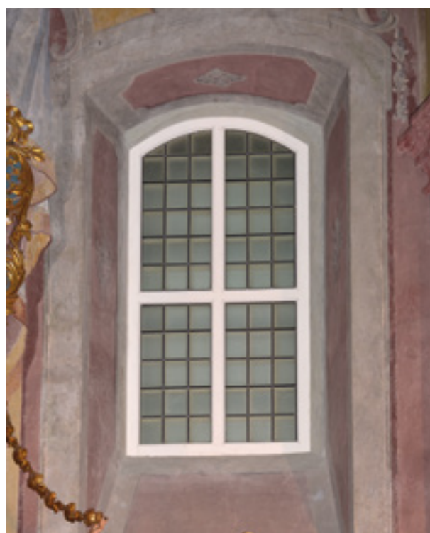
Južni prozor svetišta nakon restauratorskih radova
