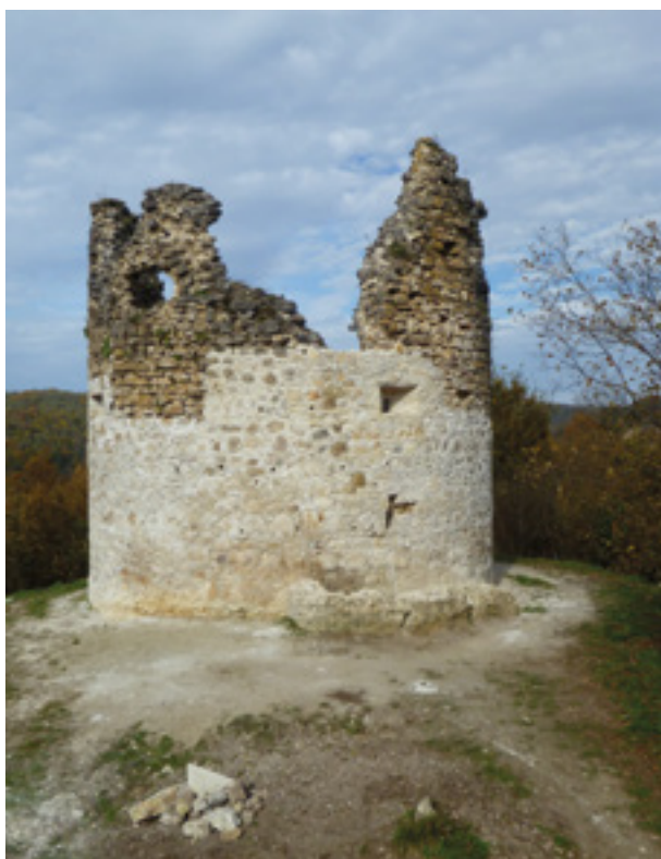
Hrvatski Čuntiće, utvrda Čuntiće, pogled na utvrdu prije početka radova u 2015. godini
