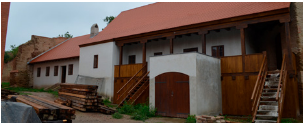
Sjeverno pročelje Kuća A i B i Kule 7, 2015.g.
