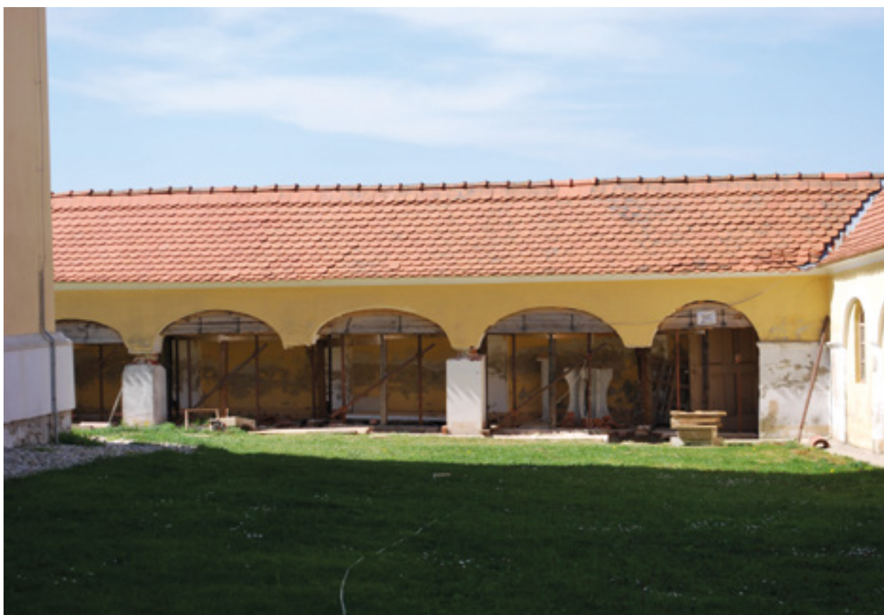
Lopatinec, stanje tijekom radova demontaže stupova
