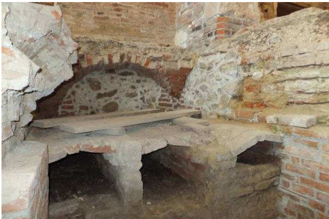
Slika 9. Kloštar Ivanić, crkva sv. Ivana Krstitelja, kripta ispod svetišta, jugozapadni ugao - nakon sanacije zida
