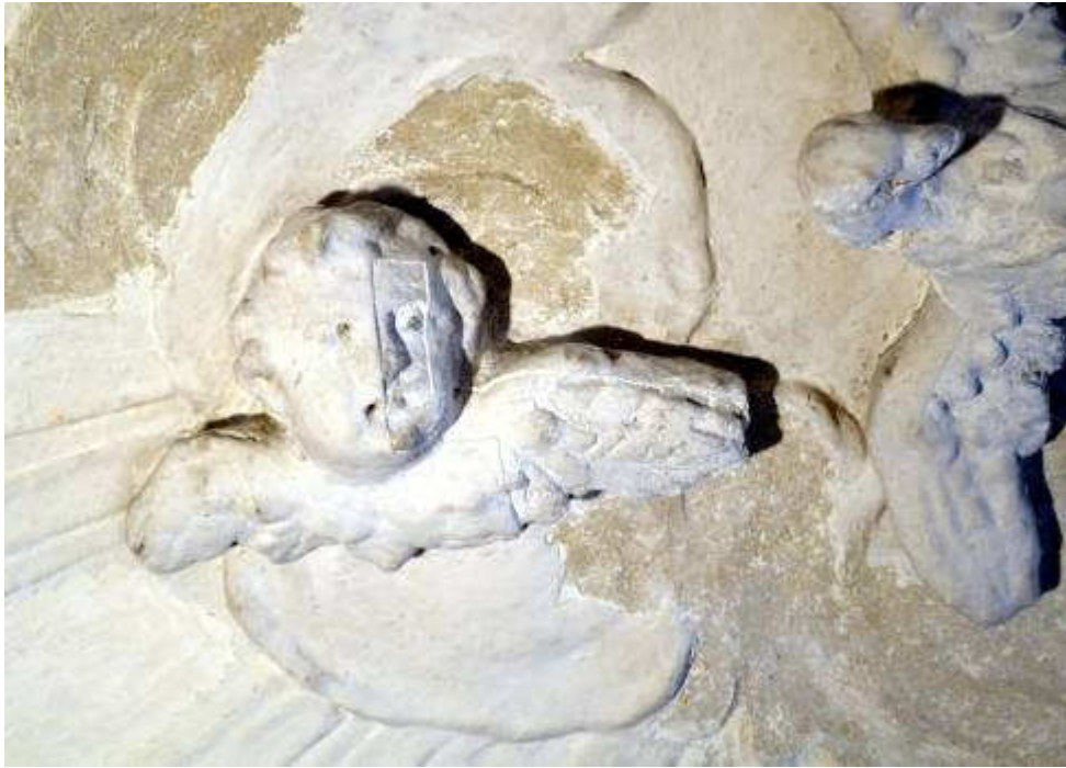
Slika 47. Krk, crkva sv. Marije Anđeoske, detalj stucco ukrasa na svodu svetišta, sondiranje bojenih slojeva
