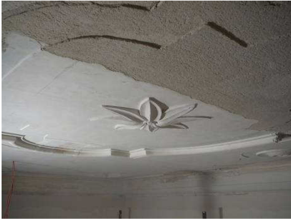
Slika 45. Dubrovnik, palača Restić, pogled na detalj stropa prostorije 7 tijekom rekonstrukcije stucco ukrasa
