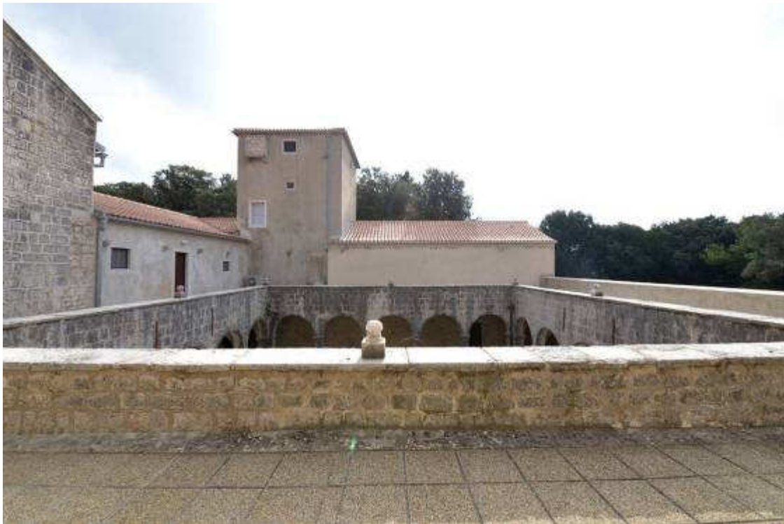
Slika 11. Košljun, kapela sv. Bernardina, nakon izvedenih radova na pokrovu
