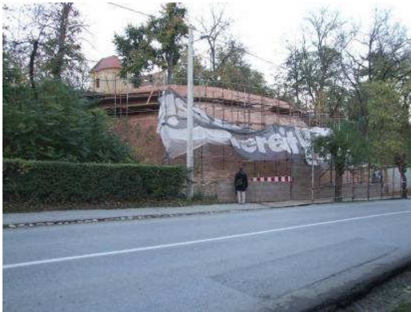
Slika 106. Ilok, pogled na obnovljeni podzid barbakana (studeni 2013.)
