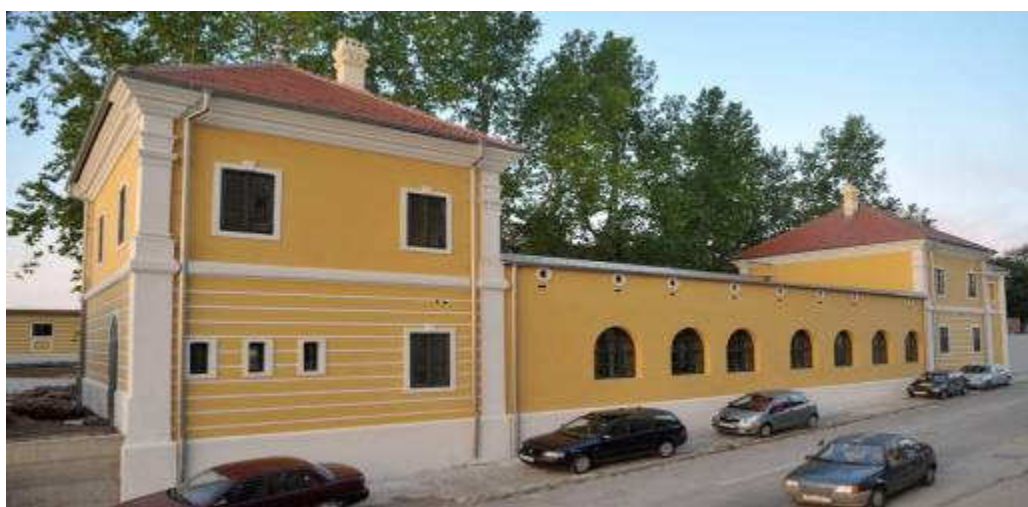
Slika 93. Vukovar, Zgrada kolnice – ulično pročelje (svibanj 2013.)
