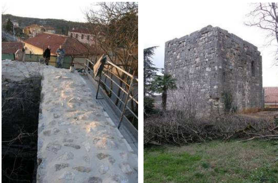
Slika 26. Barban, arhitektonski sklop crkve sv. Nikole, kule i Velih vrata - kula nakon radova
