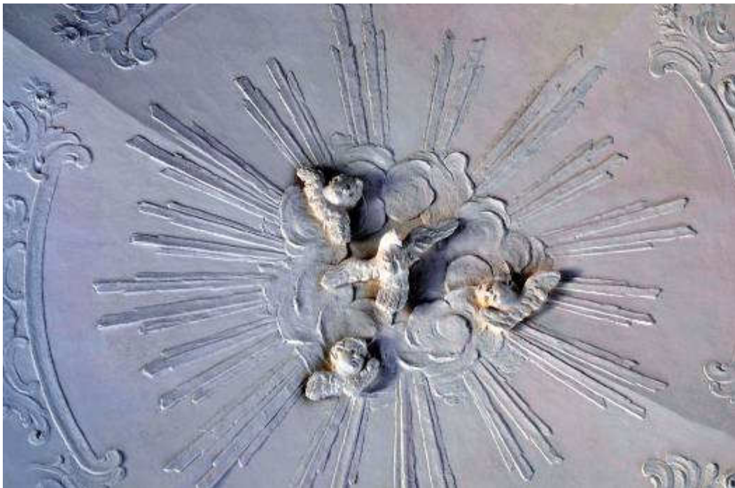
Slika 48. Krk, crkva sv. Marije Anđeoske, detalj stucco ukrasa na svodu svetišta nakon radova
