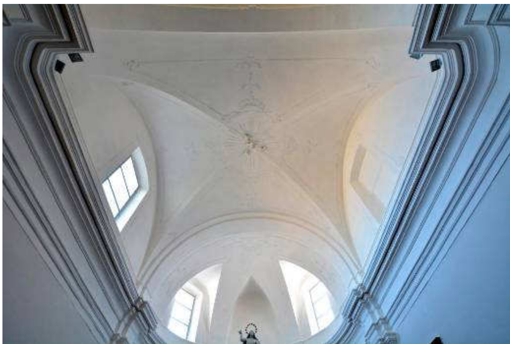
Slika 49. Krk, crkva sv. Marije Anđeoske, pogled na svod svetišta nakon radova
