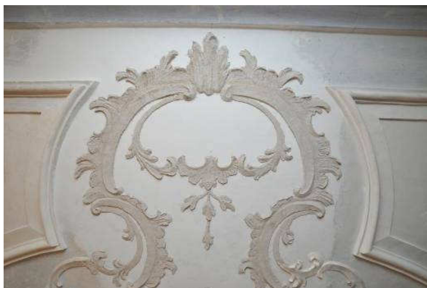
Slika 42. Buzet, crkva sv. Jurja, detalj rekonstrukcije stucco ukrasa na stropu
