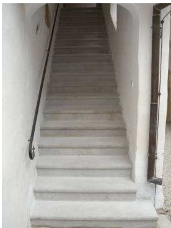
Slika 54. Radovi montaže stuba između prizemlja i prvog kata (lijevo) u tijeku radova i (desno) nakon radova)
