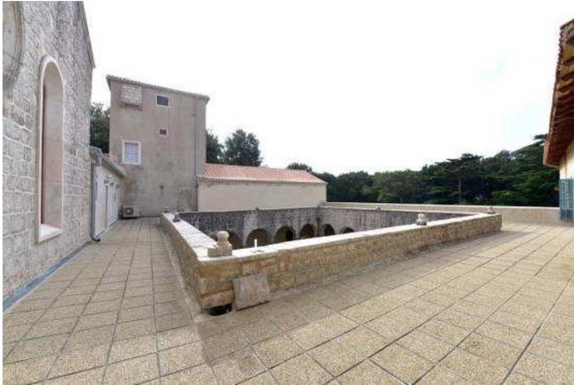
Slika 10. Košljun, kapela sv. Bernardina, nakon izvedenih radova na pokrovu
