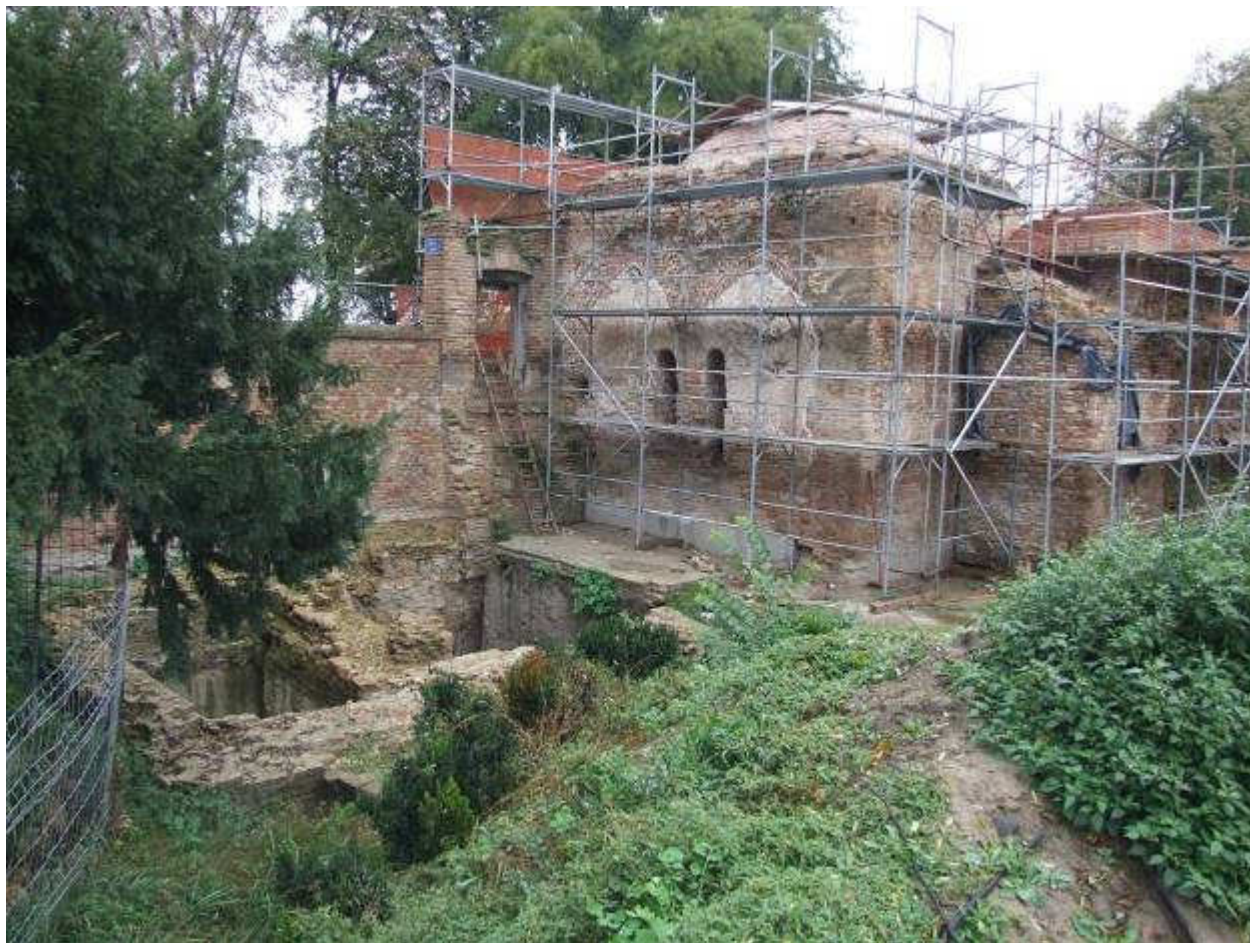
Slika 105. Ilok, pogled na zapadno i južno pročelje hamama, tijekom radova (listopad 2013.)
