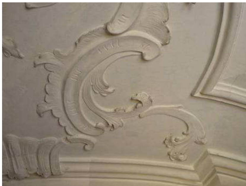
Slika 41. Buzet, crkva sv. Jurja, detalj stucco ukrasa tijekom uklanjanja preslika
