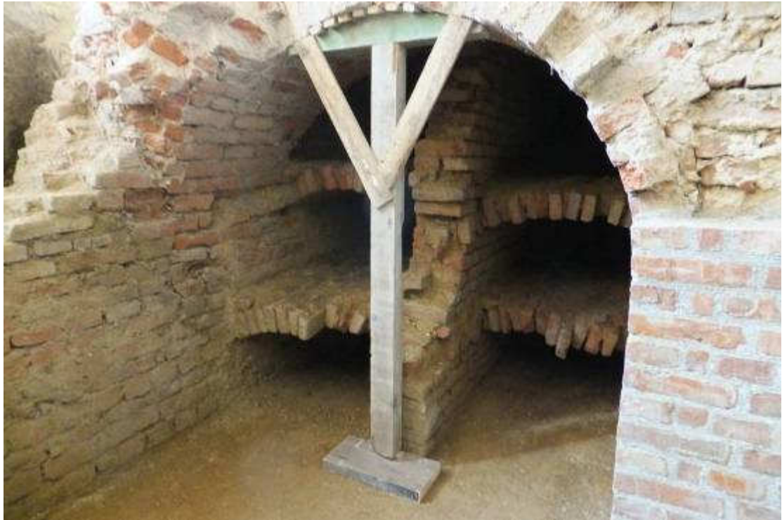
Slika 8. Kloštar Ivanić, crkva sv. Ivana Krstitelja, kripta ispod svetišta - privremeno podupiranje svoda
