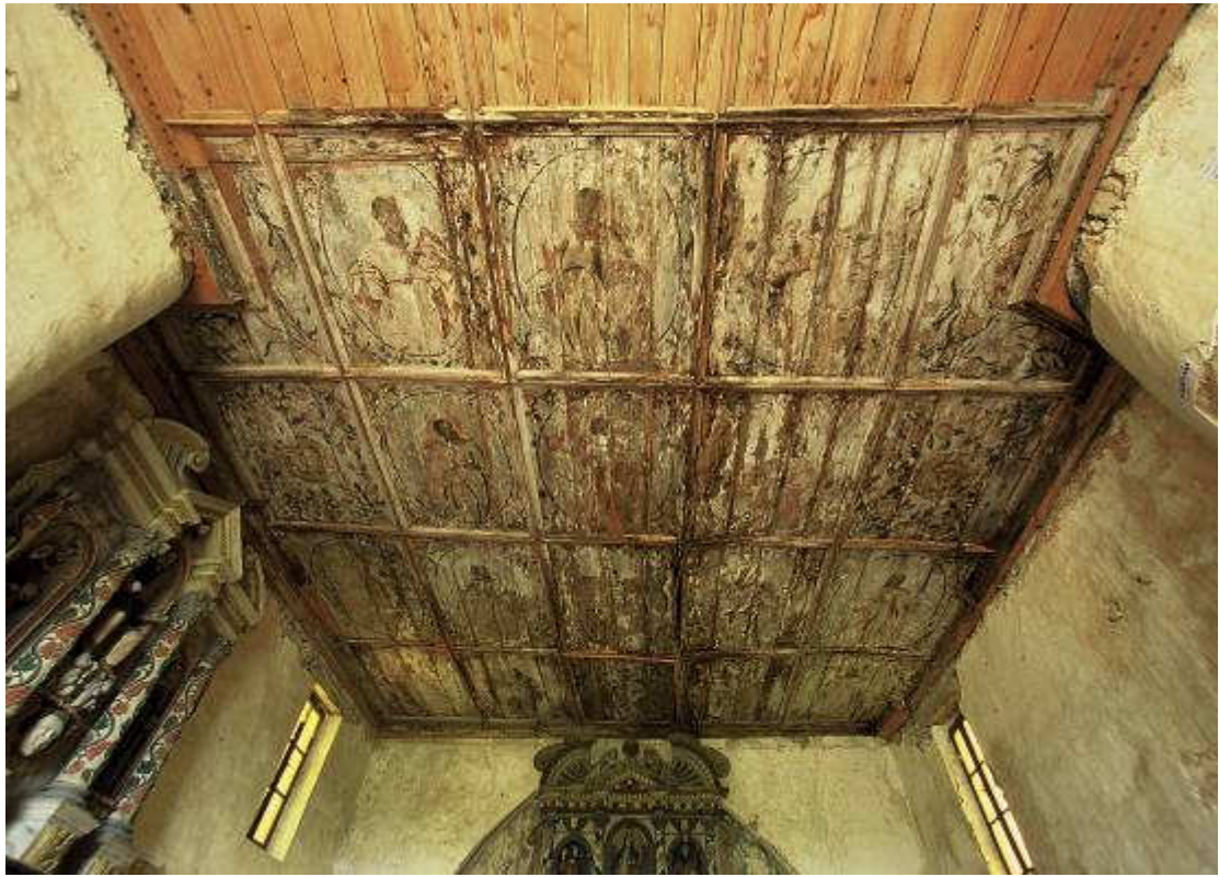
Slika 60. Trviž, crkva sv. Petra i Pavla, stanje tabulata in situ, prije demontaže
