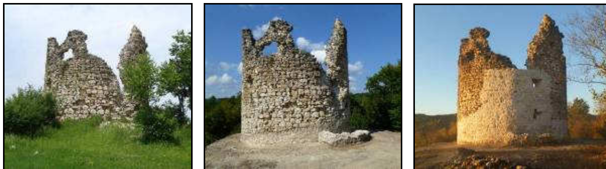
Slika 85. Stanje utvrde Čuntić u Hrvatskom Čuntiću (slijeva nadesno): prije početka radova, nakon arheoloških istraživanja te nakon konzervatorsko-restauratorskih građevinskih radova
