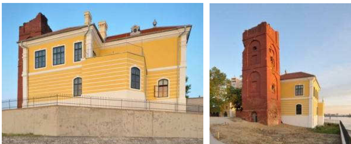
Slika 95. Vukovar, Sjeminarska stanica, sjeverno i istočno pročelje s Vodotornjem (svibanj 2013.)
