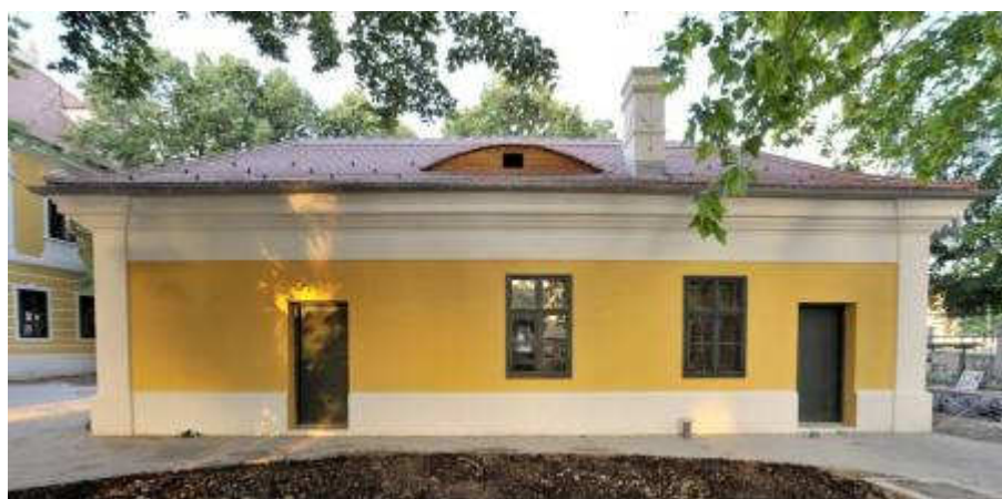
Slike 96. Vukovar, Kuća vrtlara, pogled na južno pročelje (gore) i sjeverno pročelje (dolje) (svibanj 2013.)
