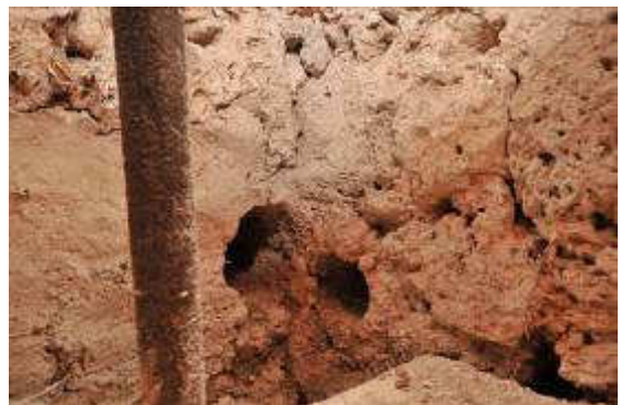
Slika 19: Izvedene bušotine u zidovima zvonika na razini drvenih gređnika za montažu zatega.
