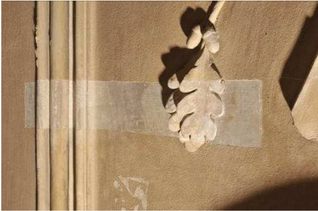
Slika 52: Rijeka, upravna zgrada bivše rafinerije šećera, plesna dvorana, svod, sondiranje slojeva.
