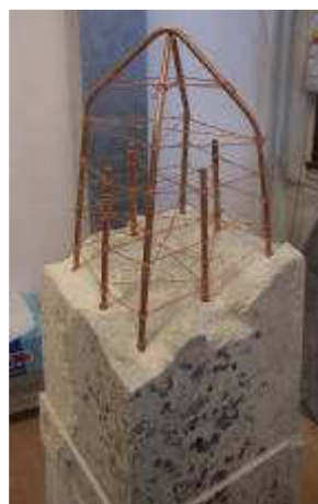
Slika 26: Lipik, Kursalon, stanje tijekom radova.
