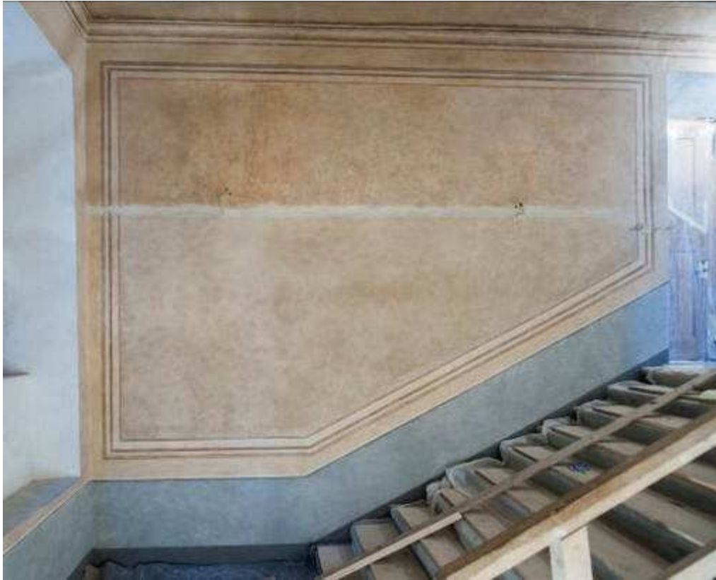
Slika 33: Dubrovnik, ljetnikovac Bunić-Kaboga, stubišni prostor, stanje nakon radova 2012.
