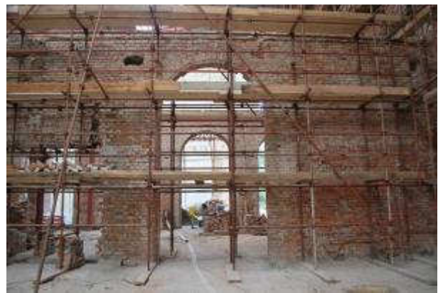
Slika 24: Lipik, Kursalon, sanirani lučni nadvoj u južnom zidu zapadnog poprečnog krila tijekom radova.
