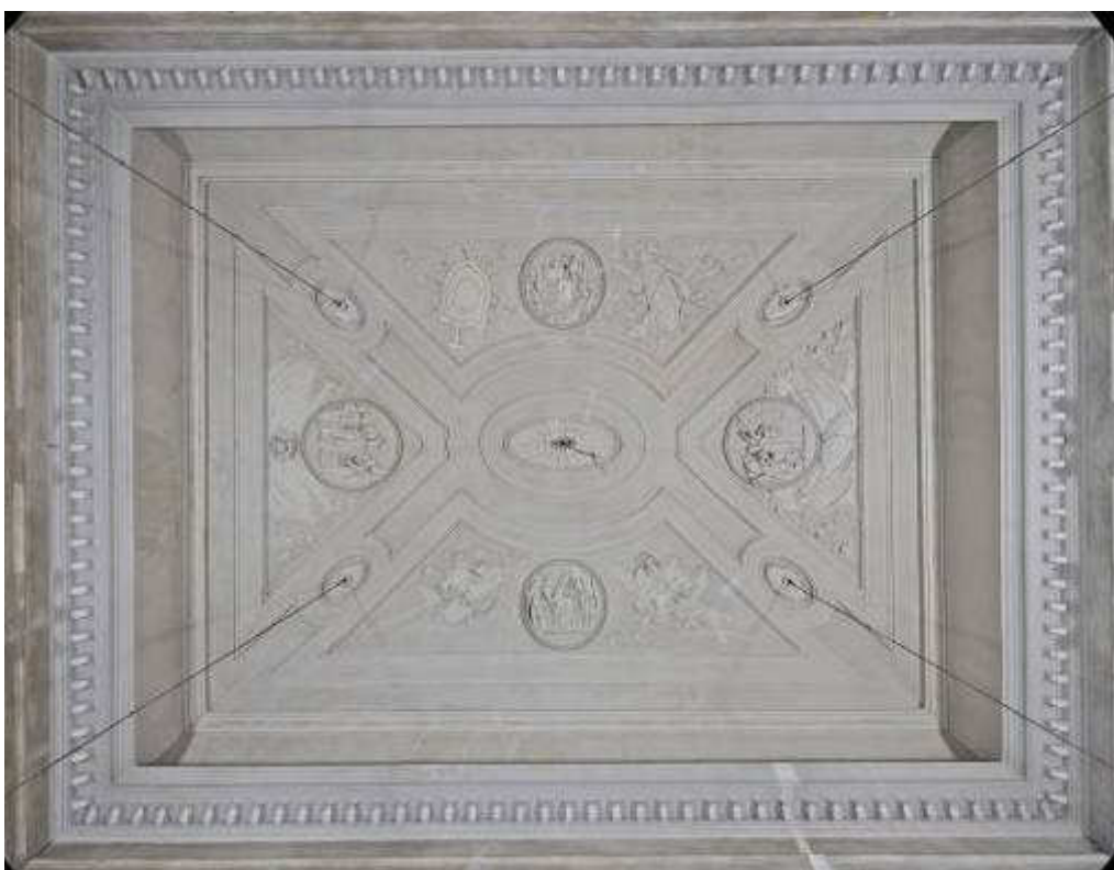
Slika 51: Rijeka, upravna zgrada bivše rafinerije šećera, plesna dvorana, svod, prije radova.
