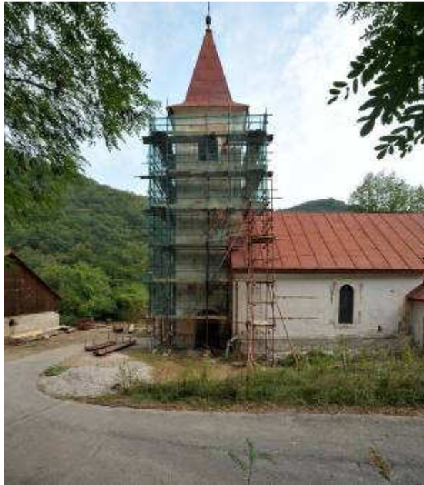
Slika 15: Žumberak, crkva Sv. Nikole, montirana skela oko zvonika, 2012.
