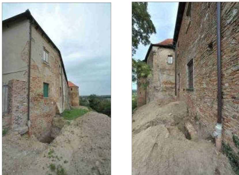
Slika 90: Ilok: istraživanje temeljenja na istočnoj i sjevernoj strani samostana.
