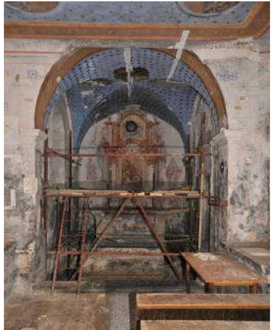
Slika 16: Montirana skela u svetištu za potrebe restauratorskih radova na zidnom osliku.
