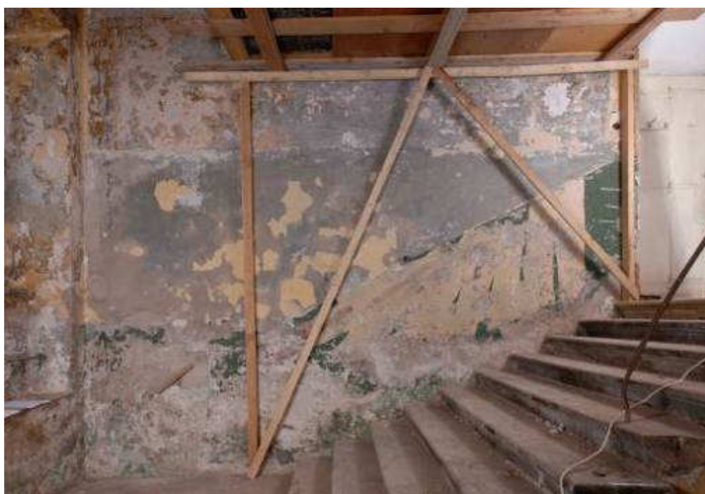
Slika 32: Dubrovnik, ljetnikovac Bunić-Kaboga, stubišni prostor, stanje prije radova.
