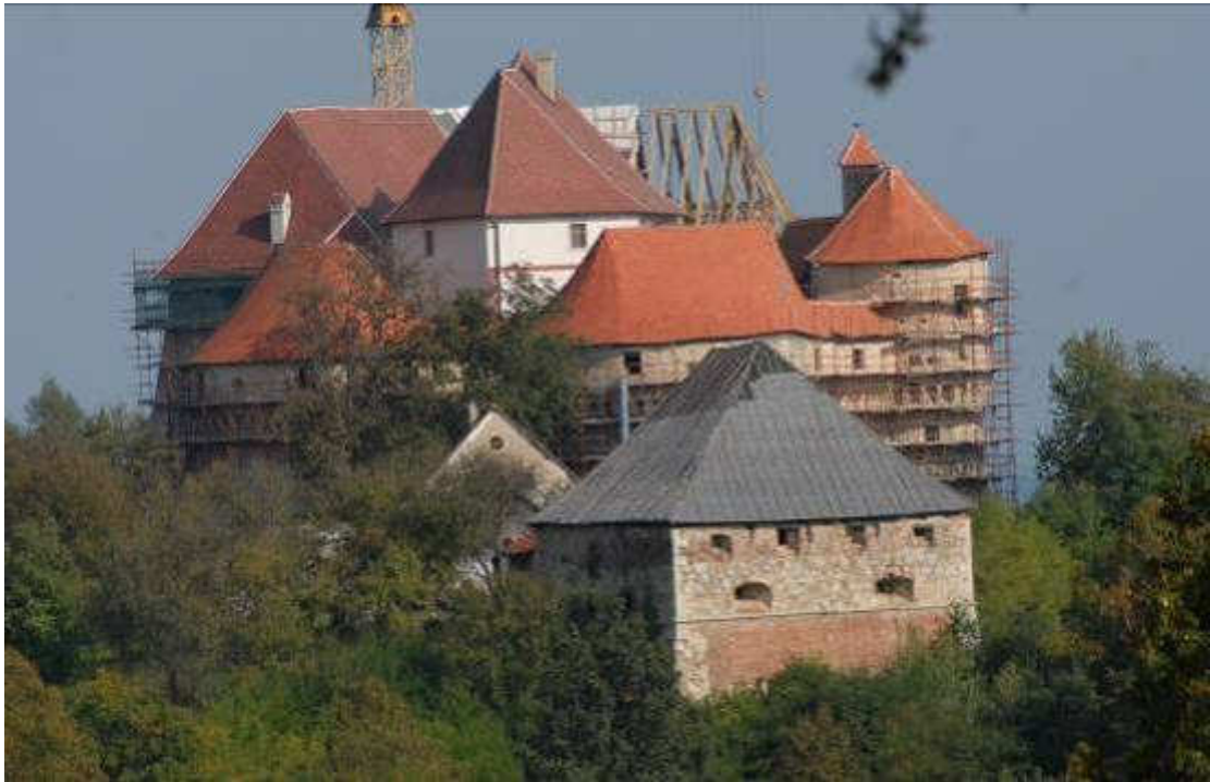
Slika 5.: Hum Košnički, Dvor Veliki Tabor, pogled sa zapada, konstruktivna i građevinska obnova, uz sanaciju krovne konstrukcije sjevernog krila i kule "D",
