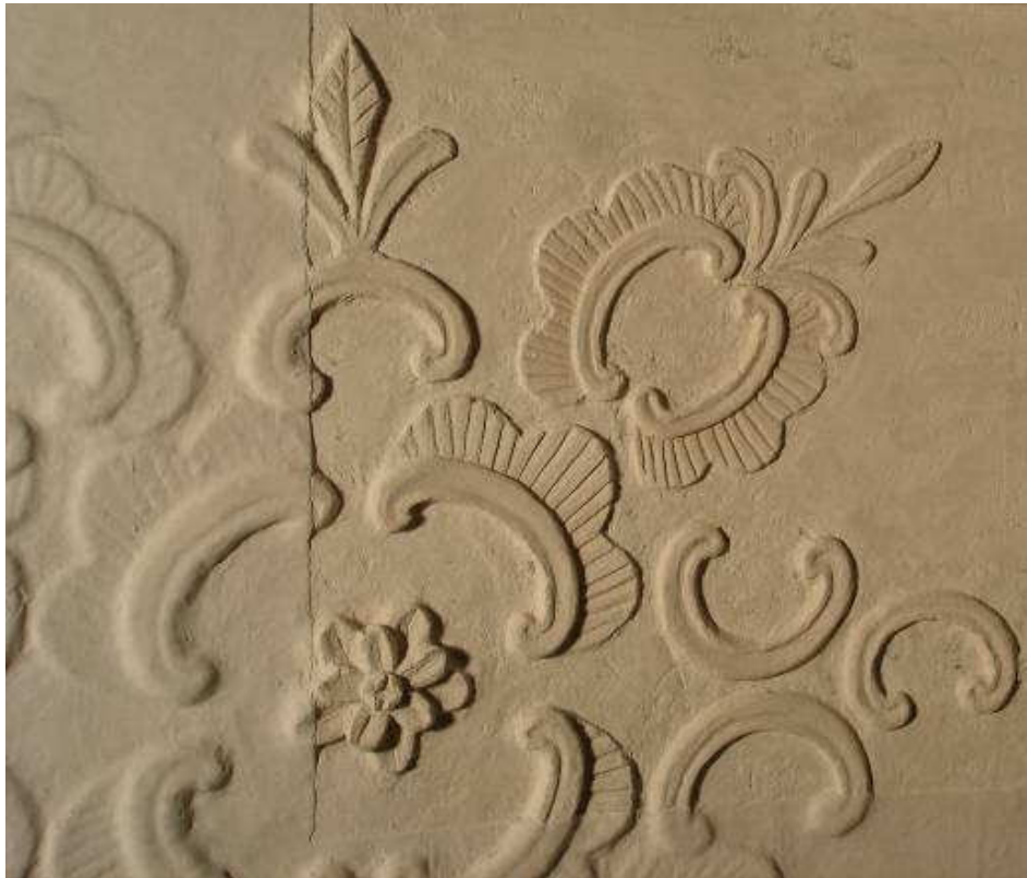
Slika 13.: Krk, crkva benediktinki sv. Marije Anđeoske; detalj štukature tijekom istraživanja i djelomičnog odstranjivanja naknadnih nalića.
