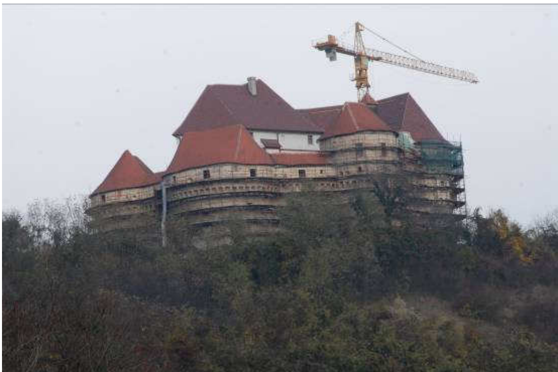
Slika 6.: Hum Košnički, Dvor Veliki Tabor, nakon obnove krovišta sjevernog krila i kule „D“.
