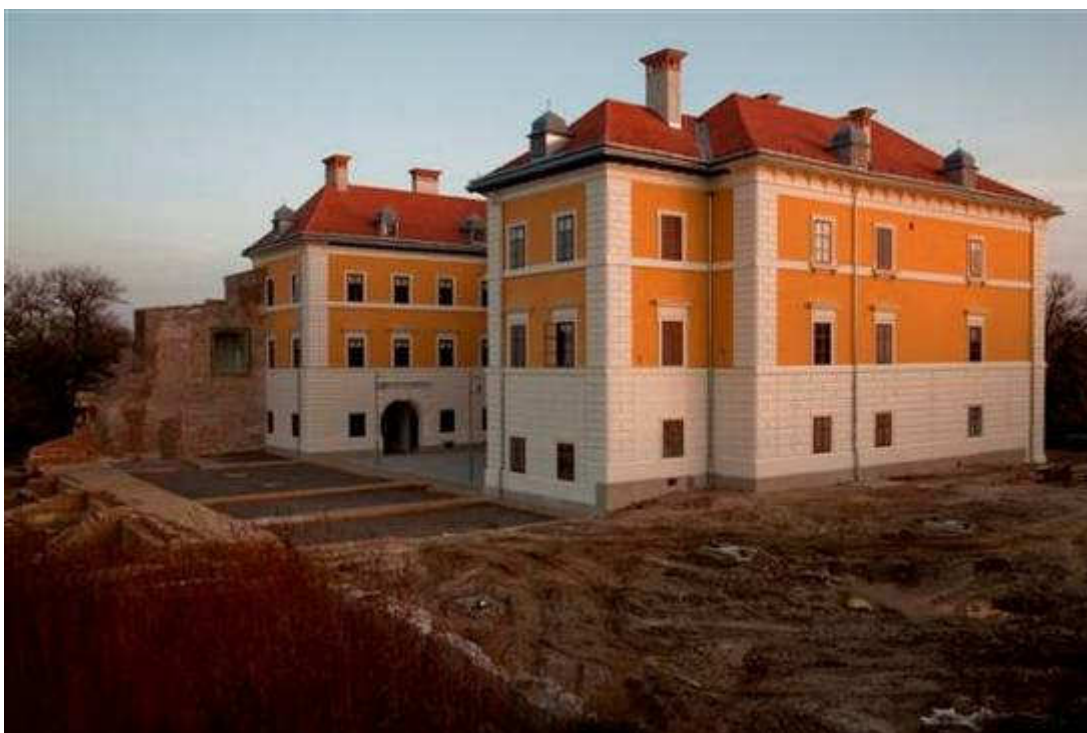
Slika 30.: Ilok, dvorac Odescalchi nakon obnove pročelja i uređenja krovišta.
