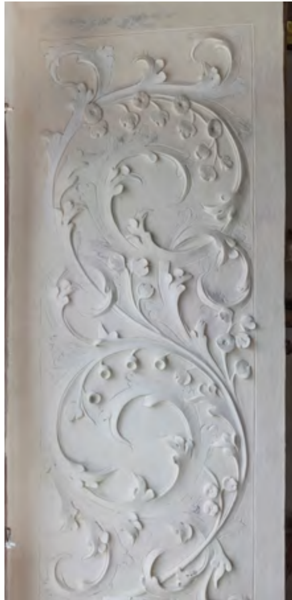
Lepoglava, bivši pavlinski samostan i župna crkva Bezgrešnog začeća Blažene Djevice Marije – bivša knjižnica. Štukatura u niši prozora na zapadnom zidu nakon čišćenja naknadnih slojeva žbuka i naliča te nakon kiparske rekonstrukcije. Snimke: J. Kliska, 2021. i K. Gavrilica 2022.
