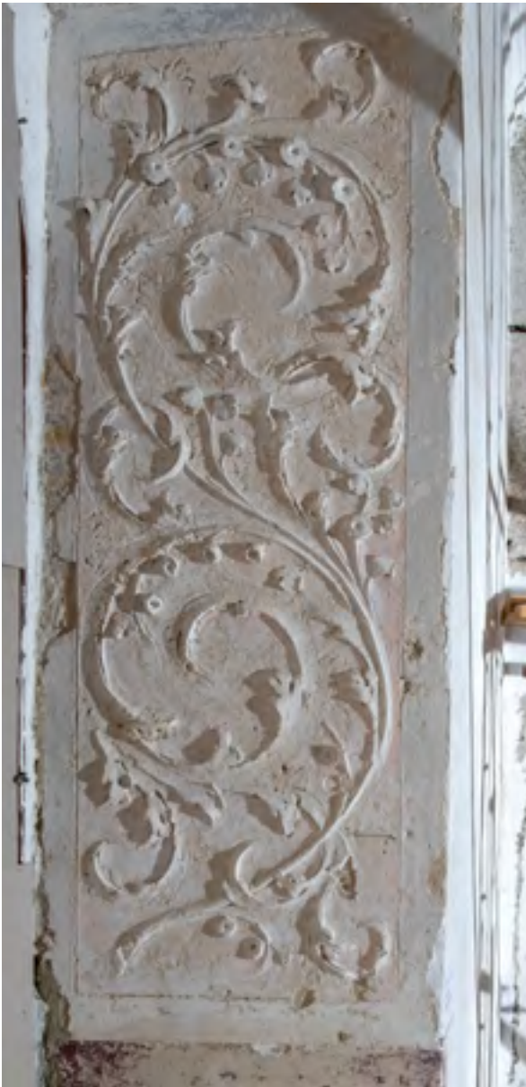
Lepoglava, bivši pavlinski samostan i župna crkva Bezgrešnog začeća Blažene Djevice Marije – bivša knjižnica. Štukatura u niši prozora na zapadnom zidu nakon čišćenja naknadnih slojeva žbuka i naliča te nakon kiparske rekonstrukcije. Snimke: J. Kliska, 2021. i K. Gavrilica 2022.
