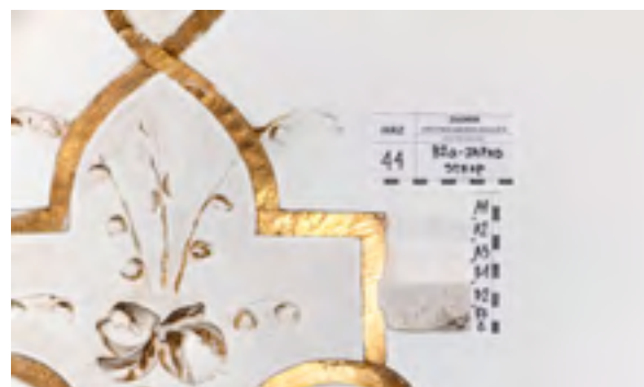
Zagreb, zgrada Hrvatskoga narodnog kazališta. Konzervatorsko-restauratorska istraživanja zidanih struktura u unutrašnjosti (strop salona mezanina). Snimka: K. Gavrilica, 2022.
