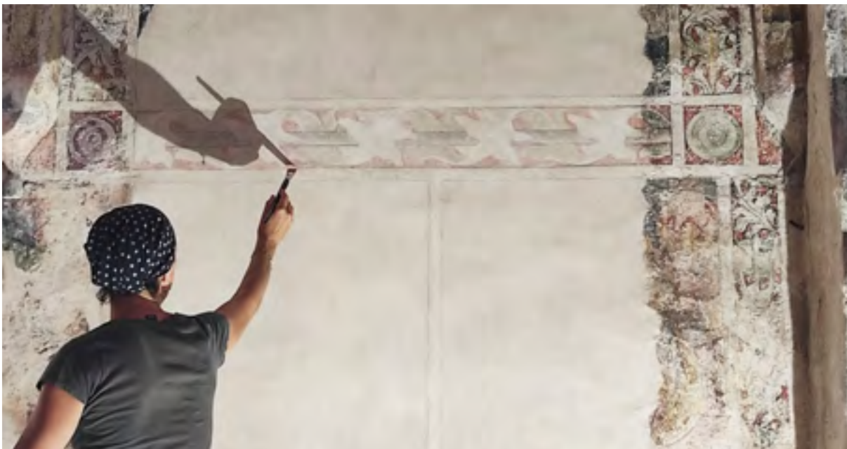
Lovran, crkva sv. Jurja mučenika. Južni zid svetišta, rekonstrukcija šablonskih elemenata oslika. Snimka: K. Krulić, 2022.
