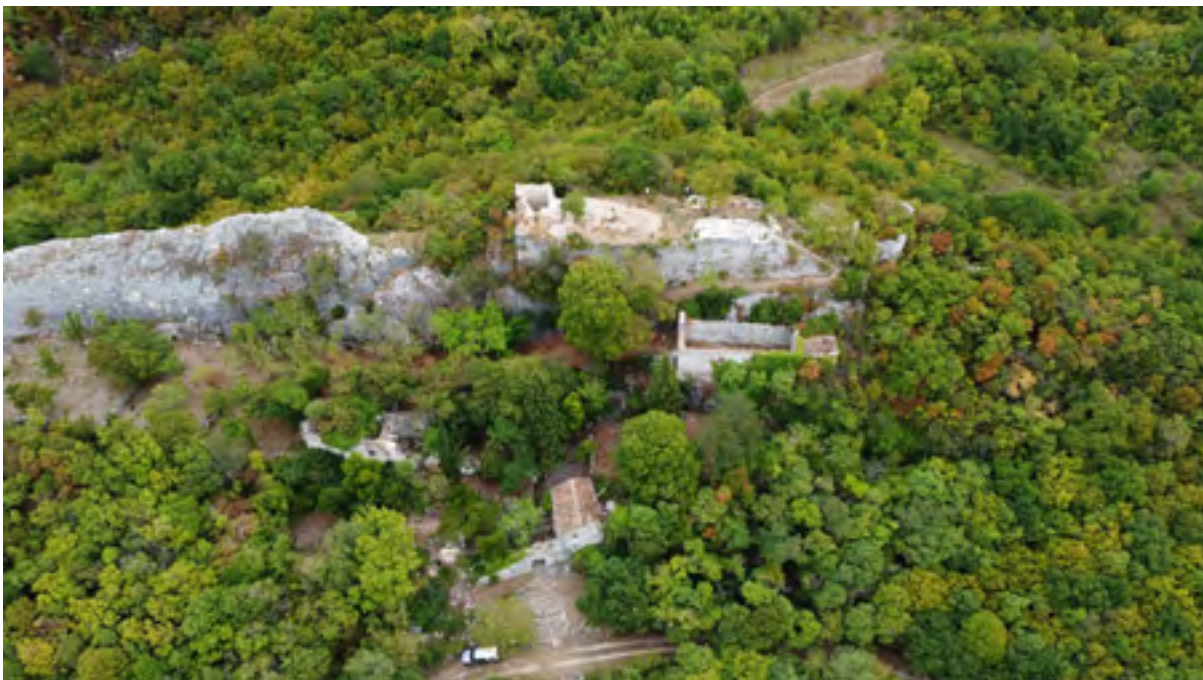
Kožljak, kaštel Kožljak. Feudalna utvrda tijekom radova. Snimka: S. Pamić, 2022.
