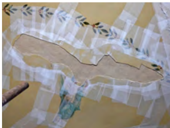
Zagreb, Opatička 10, Palača bogoštolva i nastave (Hrvatski institut za povijest). Sonda na svodu u prostoriji br. 6 u prizemlju istočnog krila palače i detalj nakon vezivanja trstike za drvenu konstrukciju stropa u Pompejanskoj dvorani. Snimke: A. Filip, 2022.
