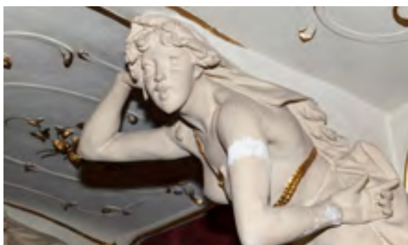
Zagreb, zgrada Hrvatskoga narodnog kazališta. Gledalište, karakteristično oštećenje karijatida loža mezanina. Snimka: K. Gavrilica, 2022.
