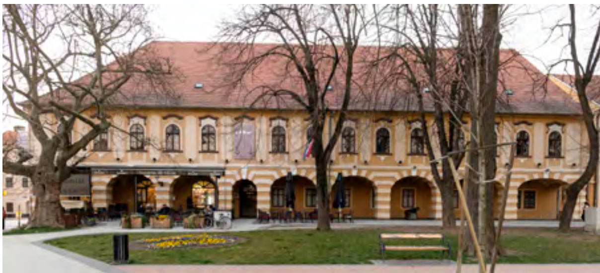
Vinkovci, zgrada Gradskog muzeja. Pogled na glavno pročelje. Snimka: I. Marinković, 2022.
