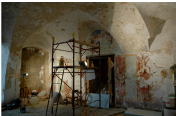
Hum Košnički, Dvor Veliki Tabor. Prvi kat, soba 8 tijekom restauratorskih radova. Fotografija: I. Srša, 2011.
