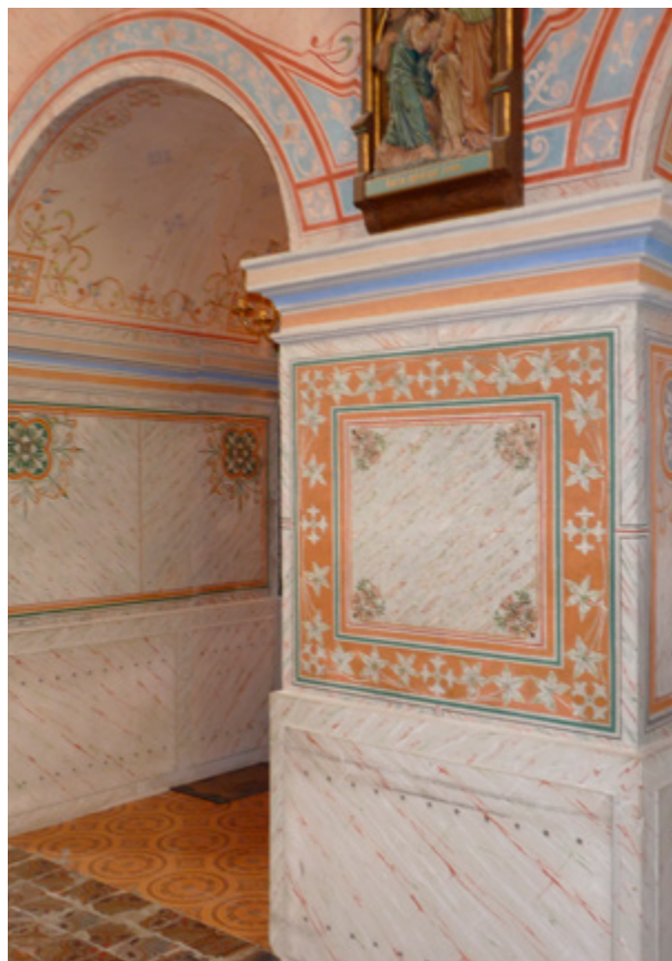
Feričanci, crkva sv. Duha. Zid niše broda nakon konzervatorsko-restauratorskih radova. Fotografija: Ž. Hnatjuk, 2016.
