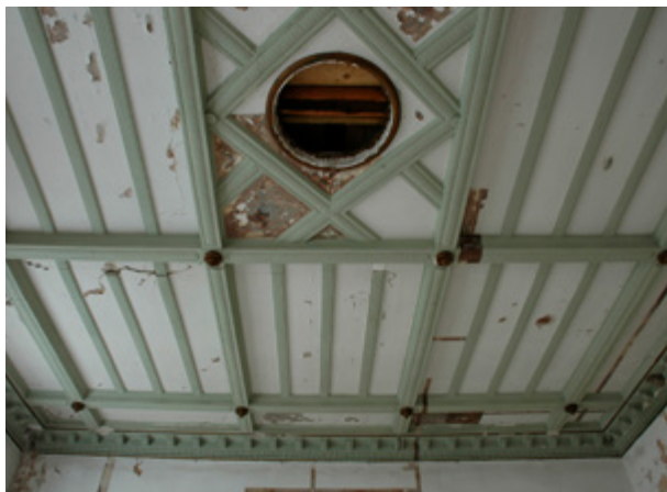
Zadar, Kneževa palača. Dvorana s kazetiranim stropom prije početka izvođenja radova. Fotografija: Z. Orčić, 2009.
