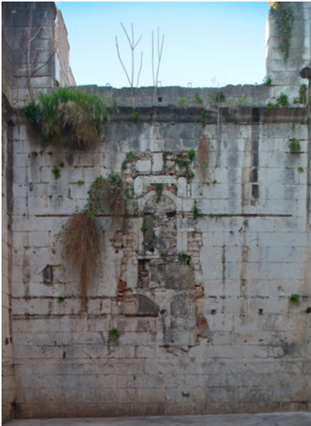
Split, Dioklecijanova palača. Unutrašnji sjeverni zid propugnakula zapadnih vrata prije početka radova. Fotografija: J. Kliska, 2014.
