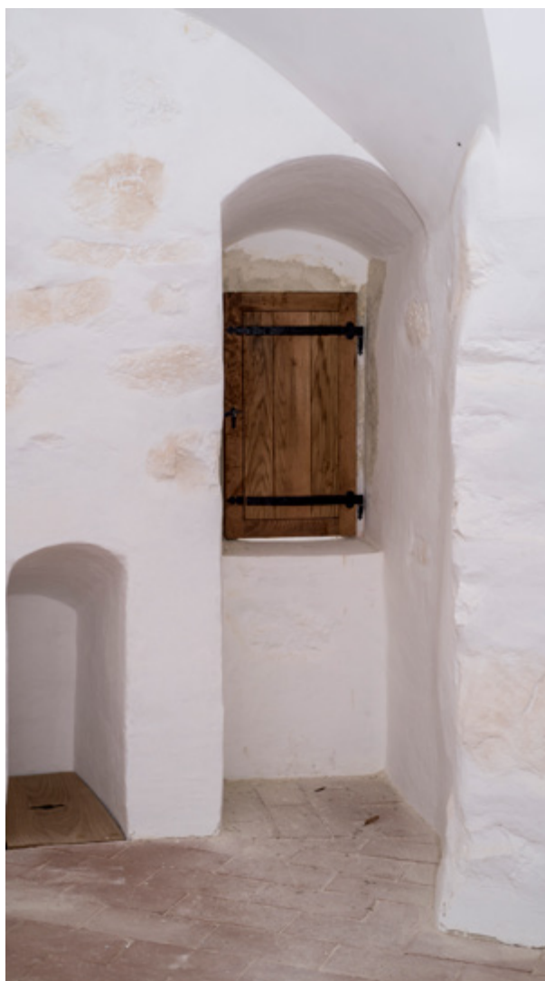
Hum Košnički, Dvor Veliki Tabor. Kula „C“, prvi kat. Detalj zatvaranja podnog (izljevna puškarnica) i zidnog otvora (puškarnica i prozor iz 16. stoljeća) drvenim kopcima. Fotografija: N. Vasić, 2016.
