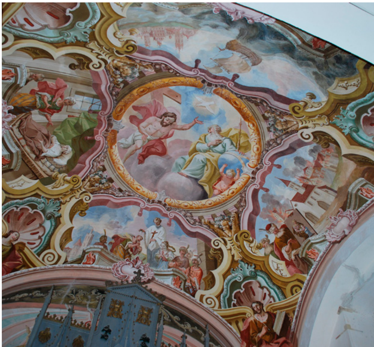
Završje Začretno, kapela sv. Ane. Svod svetišta nakon restauratorskih radova. Fotografija: M. Jelenčić, 2016.
