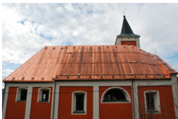
Kotari, crkva sv. Leonarda. Istočno pročelje crkve nakon radova sanacije pokrova. Fotografija: A. Škevin Mikulandra, 2016.
