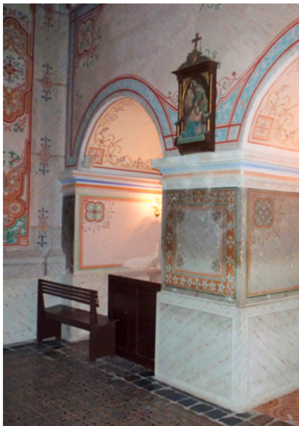
Feričanci, crkva sv. Duha. Zid niše broda prije konzervatorsko-restauratorskih radova. Fotografija: Ž. Hnatjuk, 2016.
