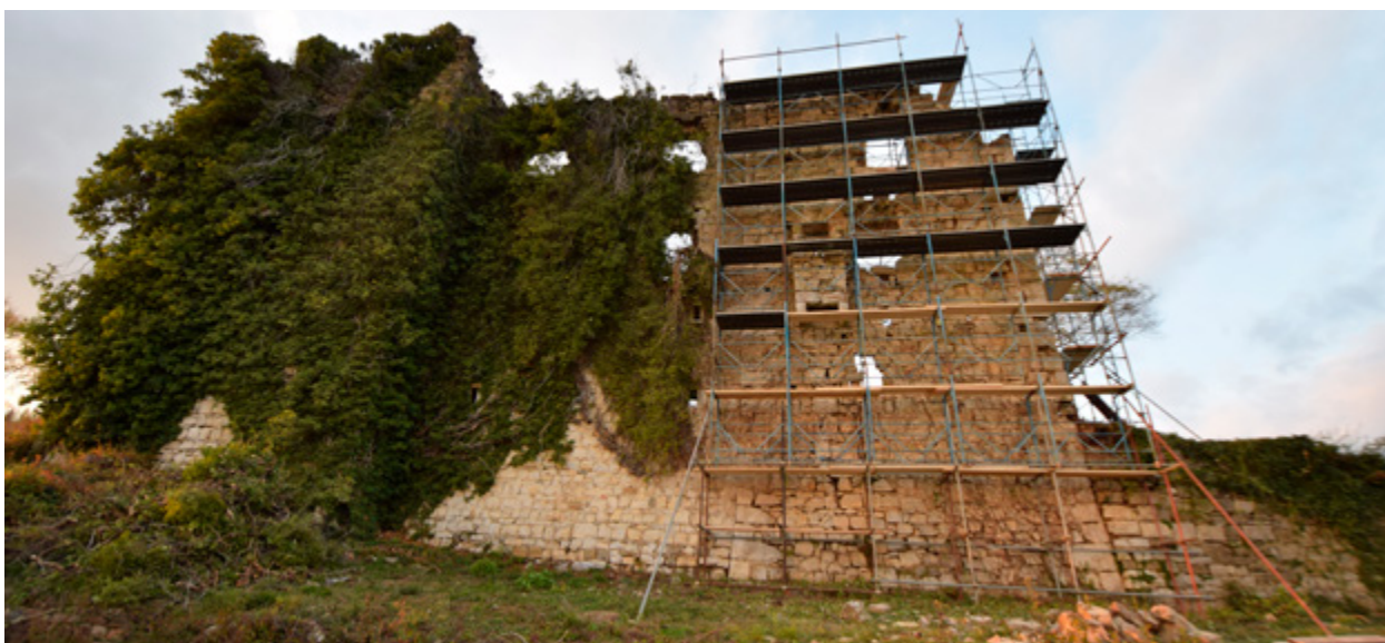
Paz, kaštel Paz. Pogled na kaštel s južne strane nakon postavljanja skele i uklanjanja bršljana. Fotografija: J. Višnjić, 2016.
