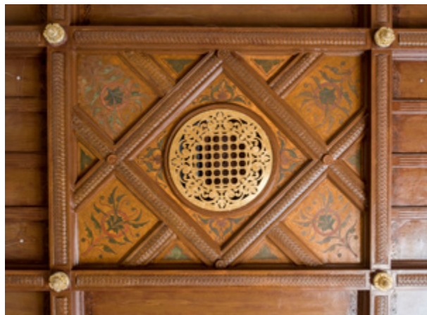
Zadar, Kneževa palača. Dvorana s kazetiranim stropom nakon konzervatorsko-restauratorskog zahvata. Fotografija: J. Kliska, 2016.
