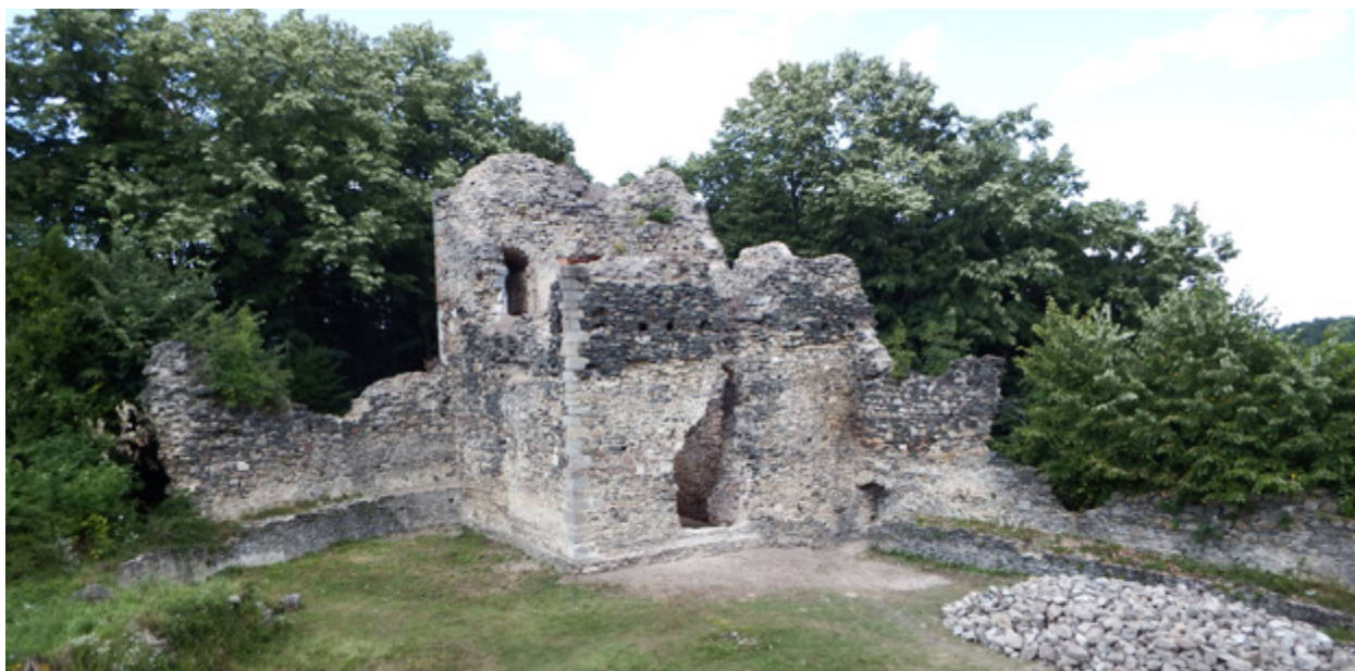
Podgarić, Stari grad Garić-grad. Pogled na malu kulu nakon dovršetka radova 2016. godine. Fotografija: T. Pleše, 2016.
