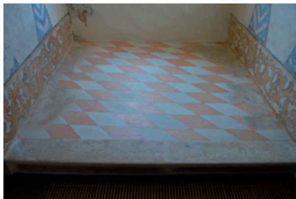
Hum Košnički, Dvor Veliki Tabor. Prvi kat, soba 8 – pod erkera nakon završetka restauratorskih radova. Fotografija: M. Jelenčić, 2016.
