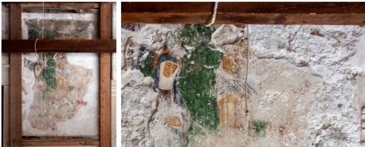
Otok Šipan, Suđurađ, crkva sv. Nikole i sv. Đurđa. Stanje zidne slike na pročelju prije i nakon radova. Fotografija: K. Gavrilica, 2016.
