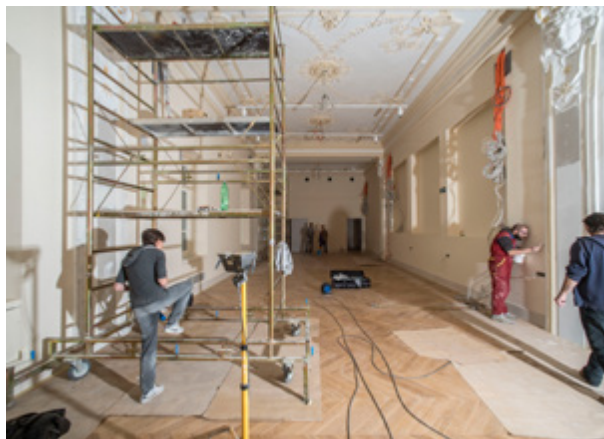
Zadar, Kneževa palača. Koncertna dvorana pred završetak konzervatorsko-restauratorskih radova. Fotografija: J. Kliska, 2016.
