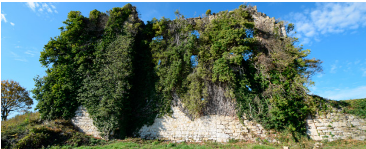
Paz, kaštel Paz. Pogled na kaštel s južne strane prije početka građevinskih radova. Fotografija: J. Višnjić, 2016.
