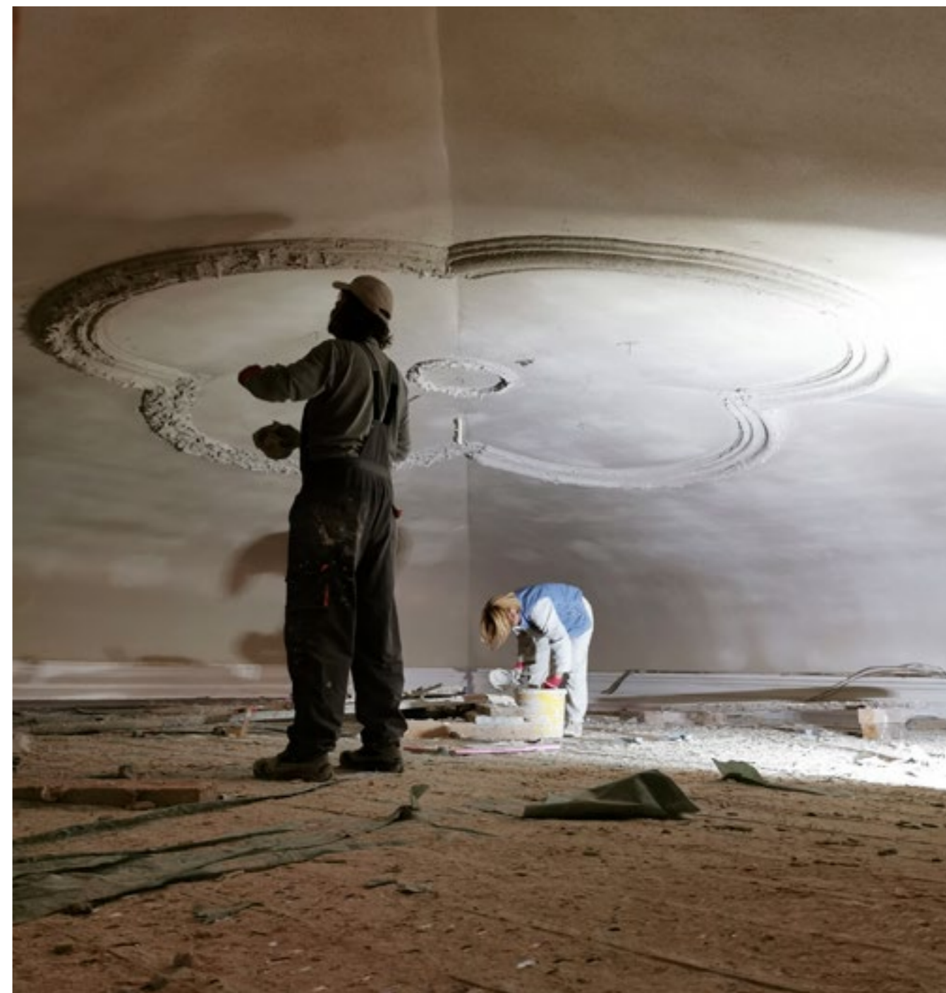
Zagreb, Nike Grškovića 23, Zidanica / ljetnikovac biskupa Galjufa. Štukodekoracija svoda tijekom konzervatorsko-restauratorskih radova. Snimka: B. Mostarčić, 2021.
