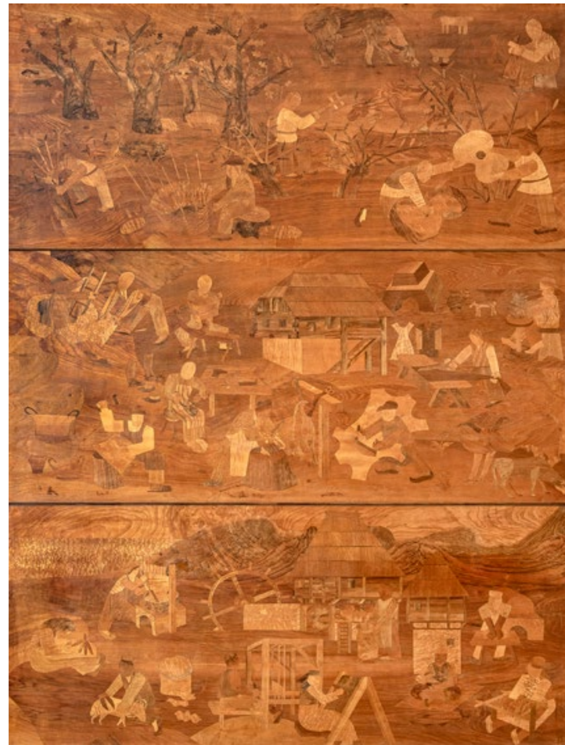
Zagreb, Hrvatska obrtnička komora. Drvena oplata zida vijećnice. Stanje nakon konzervatorsko-restauratorskih radova. Snimka: I. Marinković, 2021.
