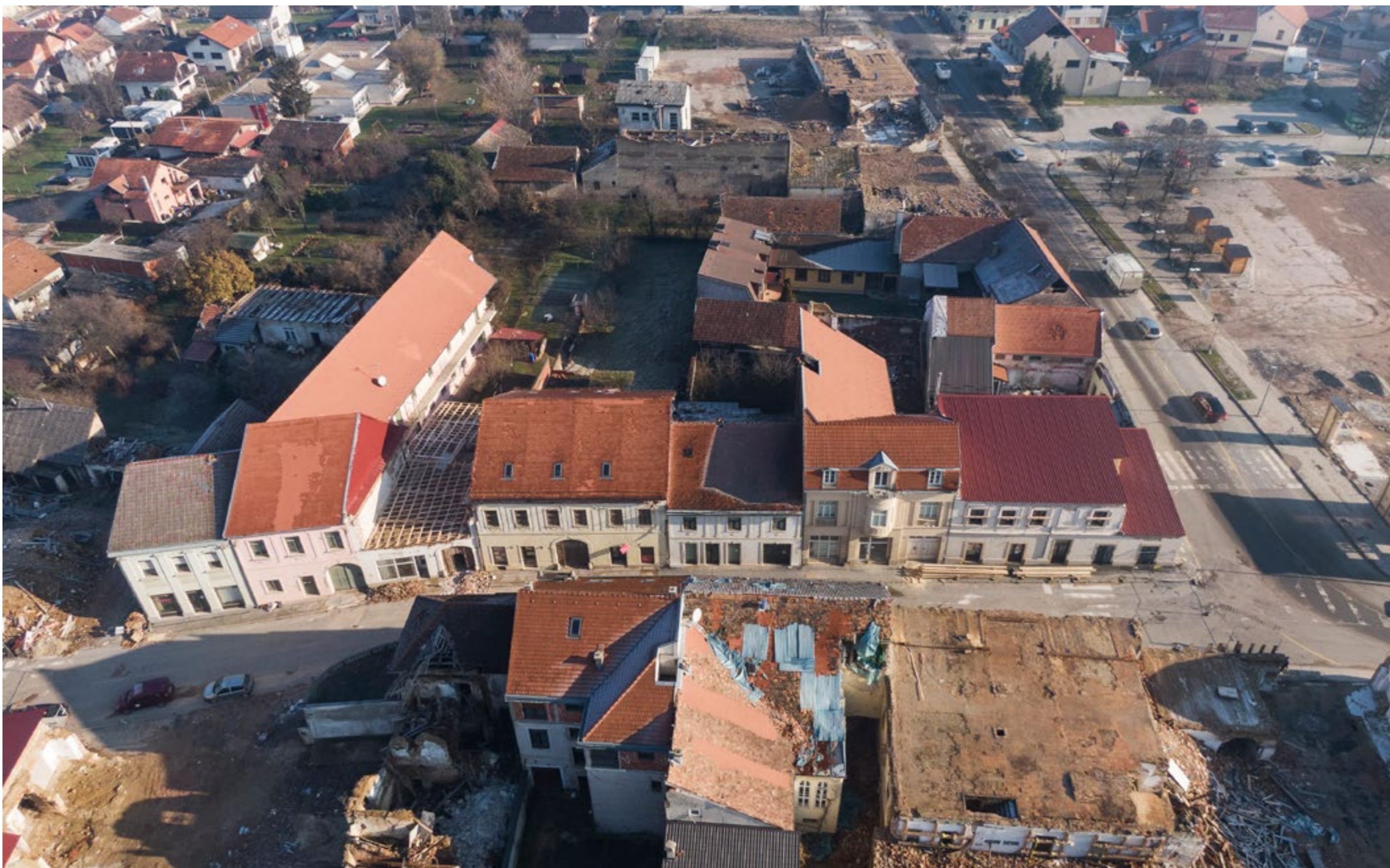
Petrinja, ulica Vladimira Nazora. Zgrade na kućnim brojevima 3, 5, 7, 8, 9, 11 i 13 tijekom izvođenja hitnih radova osiguranja konstrukcije i podupiranja. Snimka: Lj. Gamulin, 2021.
