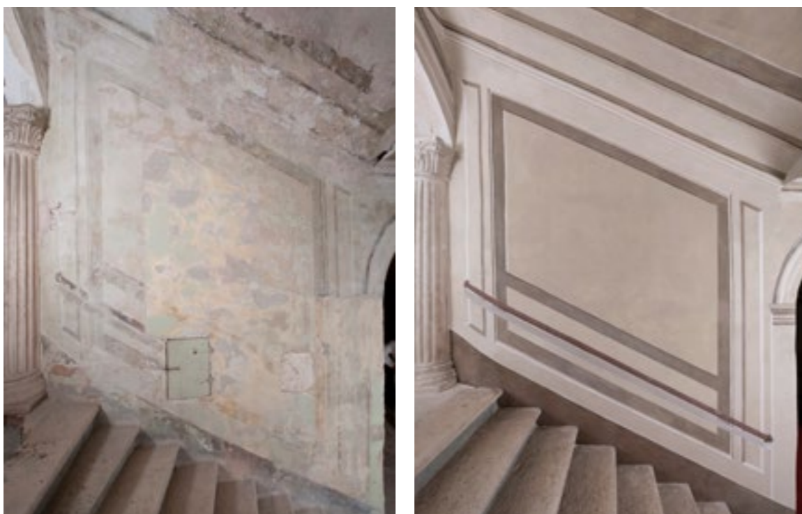
Dubrovnik, Biskupska palača (palača Sorkočević). Oslík zapadnog zida stubišta prije i nakon radova. Snimke: K. Gavrić, 2018. i Lj. Gamulin 2021.
