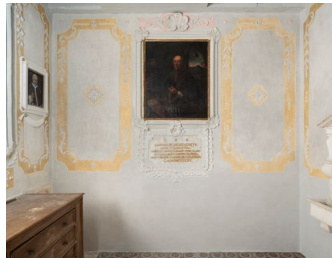
Motovun, župna crkva sv. Stjepana prvomučenika. Zapadni zid sjeverne sakristije nakon radova. Snimka: G. Tomljenović, 2021.
