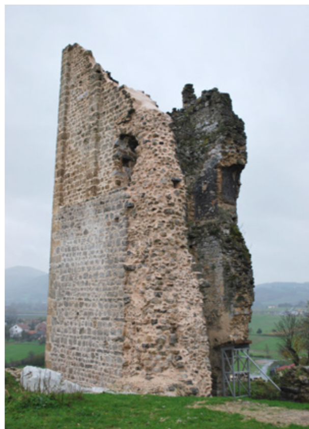
Slika 6. Stanje nakon radova 2014.
