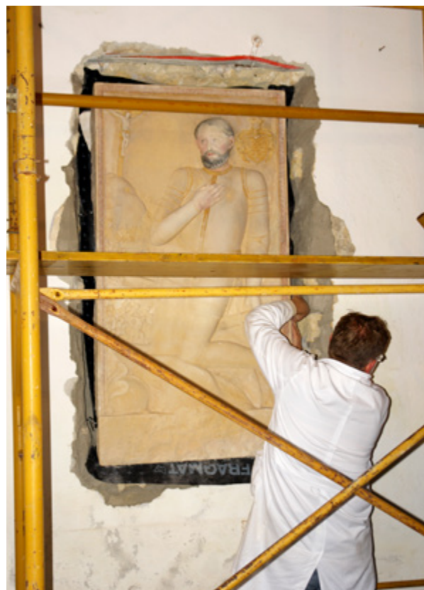
Slika 25. Nadgrobna ploča Martina Mogorića iz župne crkve Pohoda BDM u Mariji Gorici, stanje tijekom radova
