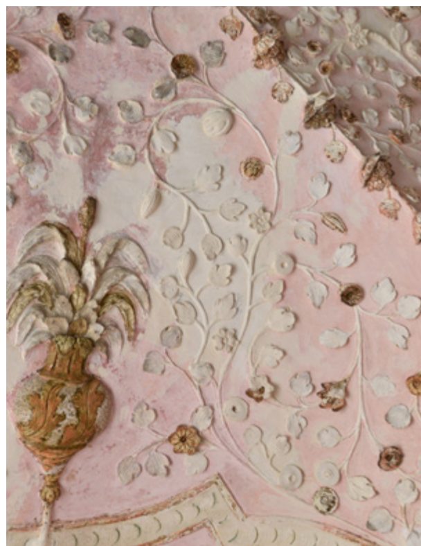
Slika 21. Komin, kapela sv. Tri kralja, rekonstrukcija nedostajućih detalja štukature
