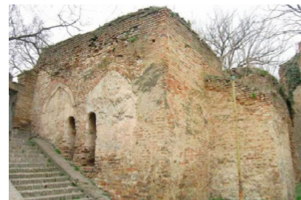
Slika 75. Ilok, pogled na zapadno i južno pročelje hamama prije radova
