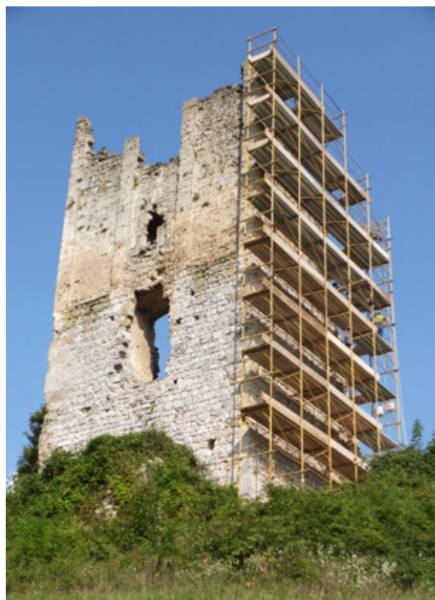
Slika 5. Brinje, Frankopanska kula, stanje tijekom radova 2014.
