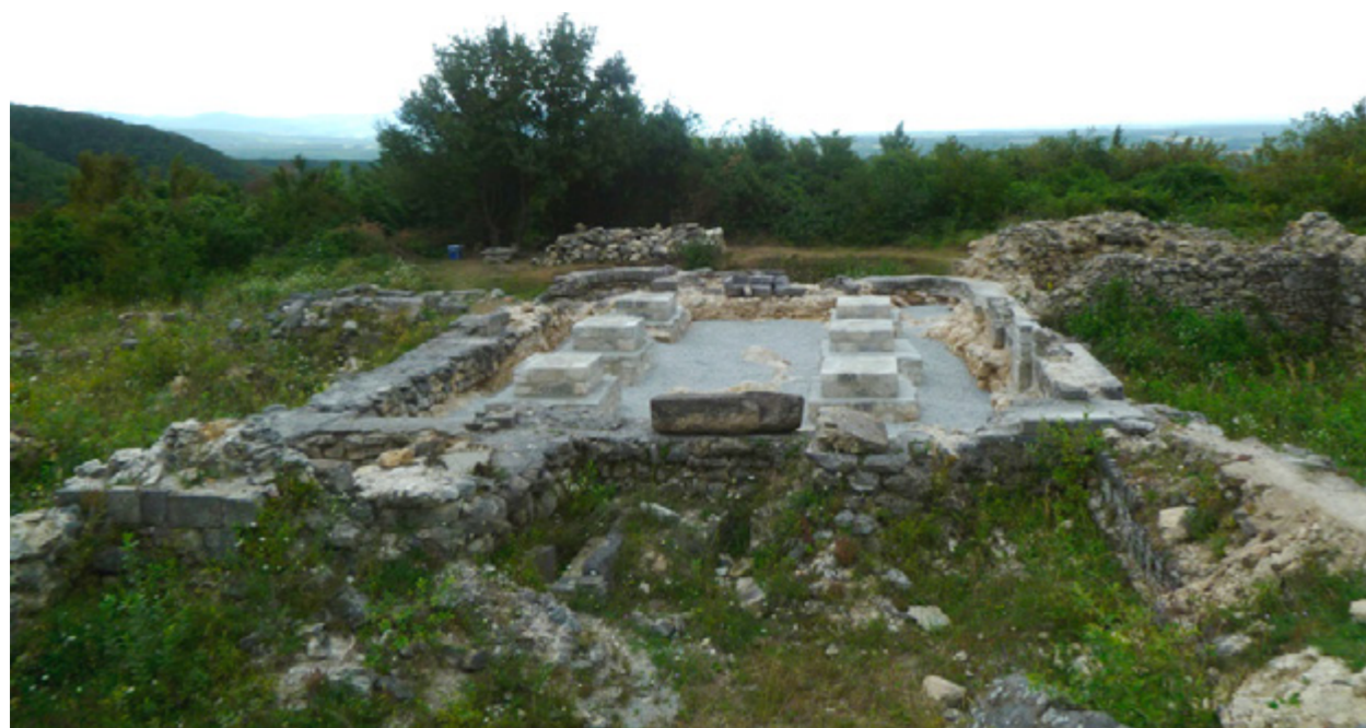
Slika 60. Stanje nakon građevinskih radova na konzerviranju i rekonstrukciji temelja i baza stubova
