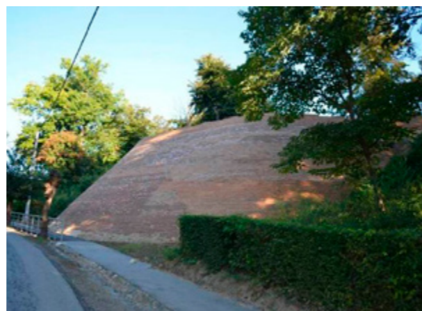
Slika 78. Pogled na obnovljeni podzid barbakana
