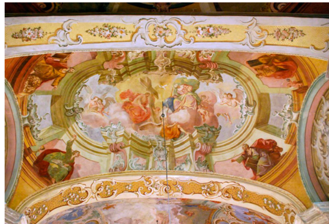
Slika 18. Stanje nakon radova
