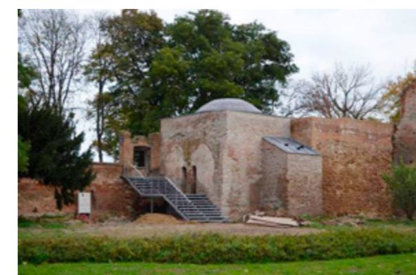
Slika 76. Pogled na zapadno i južno pročelje hamama, tijekom radova
