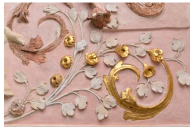
Slika 22. Detalj štukature, probe retuša pozlate i oslika
