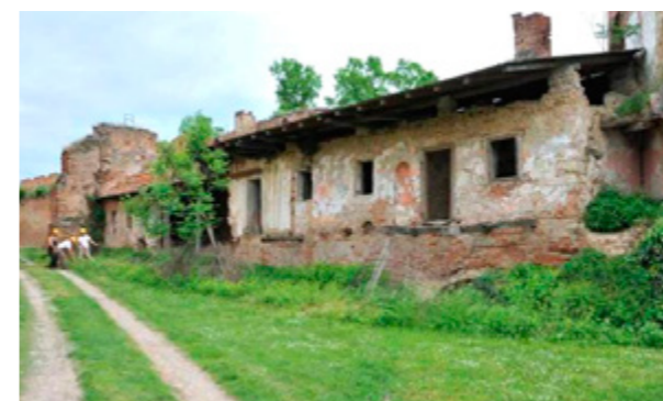
Slika 73. Ilok, kuće A i B tijekom istražnih radova
