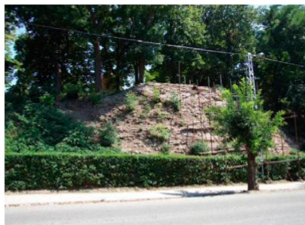
Slika 77. Ilok, podzid barbakana nakon čišćenja samoniklog raslinja
