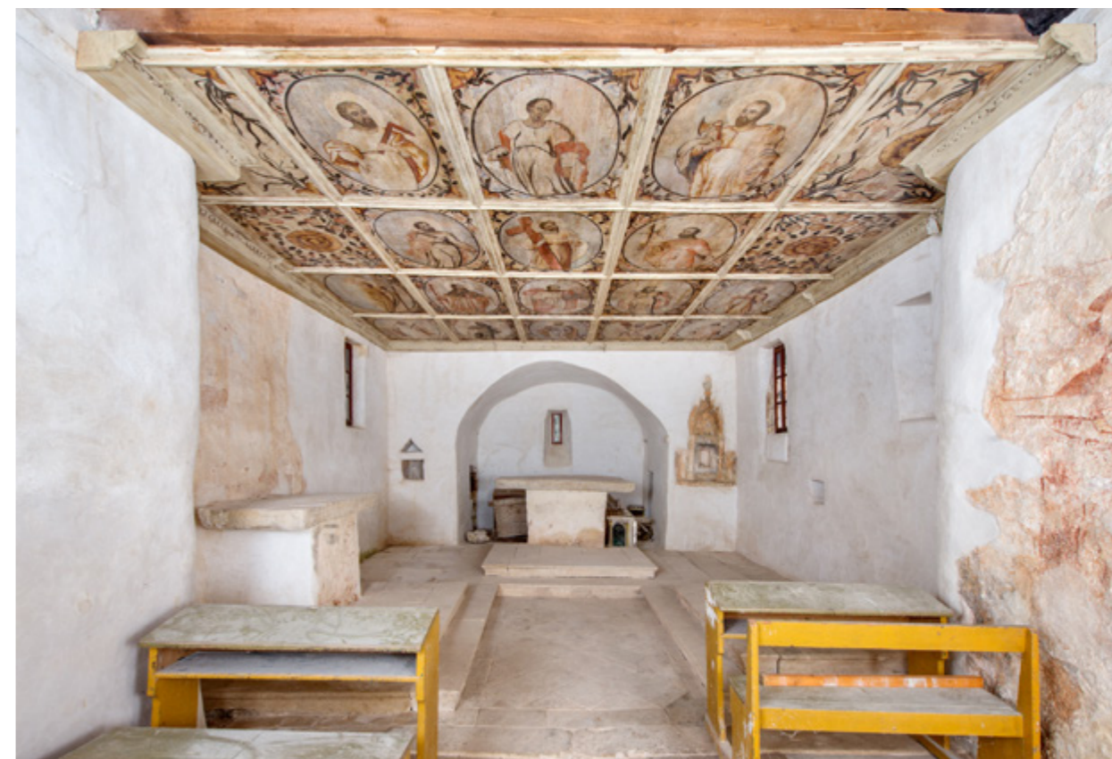
Slika 30. Stanje nakon radova
