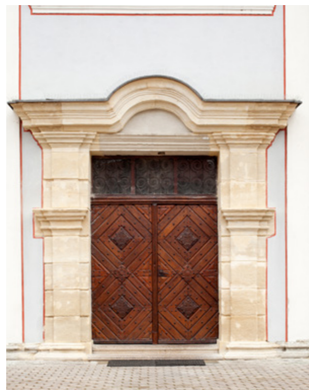
Slika 28. Stanje nakon radova
