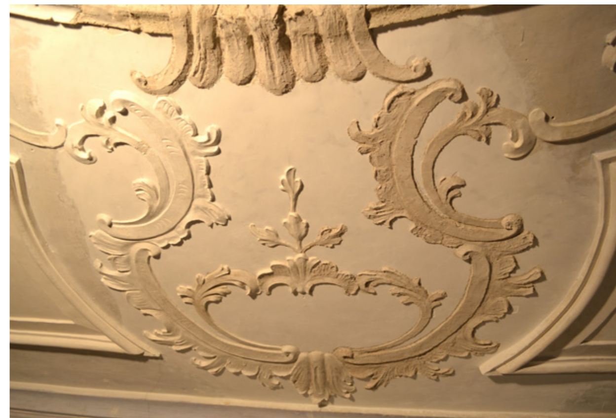
Slika 20. Štukatura na stropu tijekom rekonstrukcije
