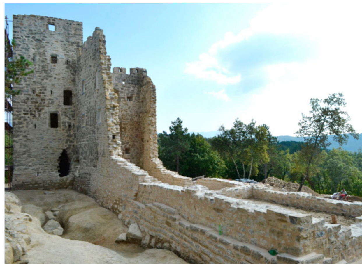
Slika 61. Utvrda Possert tijekom radova
