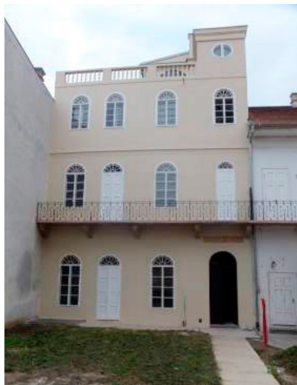
Slika 65. Vukovar, Kuća Paunović, Ul. F. Tuđmana 7, dvorišno pročelje, stanje nakon obnove
