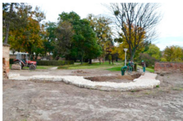
Slika 80. Pogled na obnovljeni podzid barbakana
