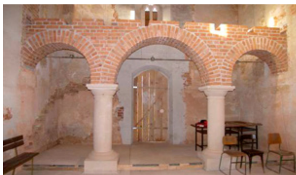
Slika 13. Novo Mjesto, kapela sv. Petra, zidana konstrukcija pjevališta
