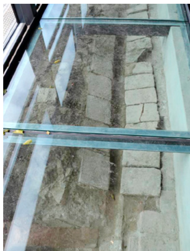
Slika 72. Ilok, odvodni kanal na stražarskoj stazi obrambenog zida istočno od kule 5, pronađen tijekom građevinskih radova 2013., prezentacija nalaza 2014.
