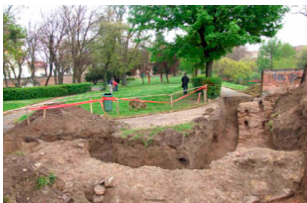
Slika 79. Ilok, podzid barbakana nakon čišćenja samoniklog raslinja
